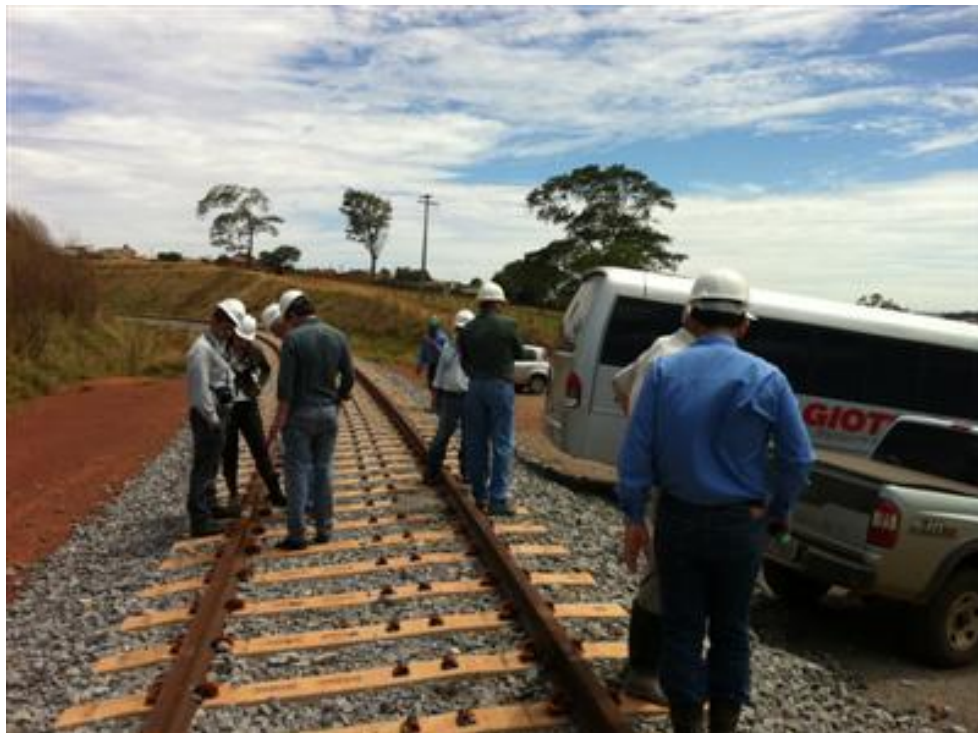
Foto 06: Trecho da Ferrovia Norte-Sul, próximo ao Túnel 1, sendo inspecionada em Anápolis/GO 5
