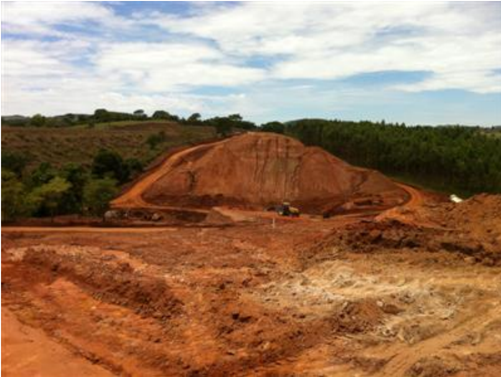
Foto 07: Obras de interligação da Ferrovia Norte Sul com a Extensão Sul dessa Ferrovia, município de Ouro Verde de Goiás 6
