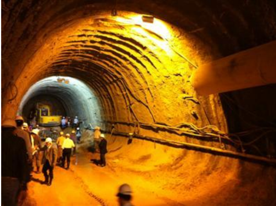
Foto 01: Ferrovia Norte-Sul, Túnel 2, em construção, em Anápolis/GO 2
