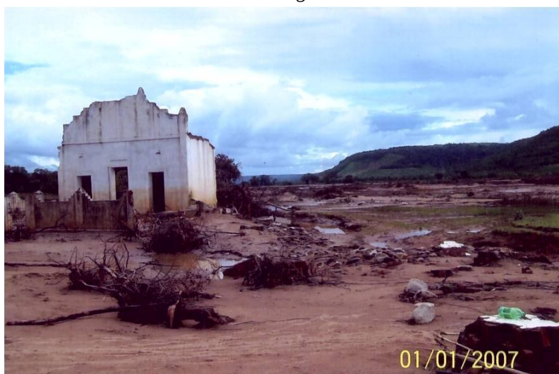
Foto 12 – Barragem Algodões I – destruição de comunidade rural em decorrência do rompimento.
