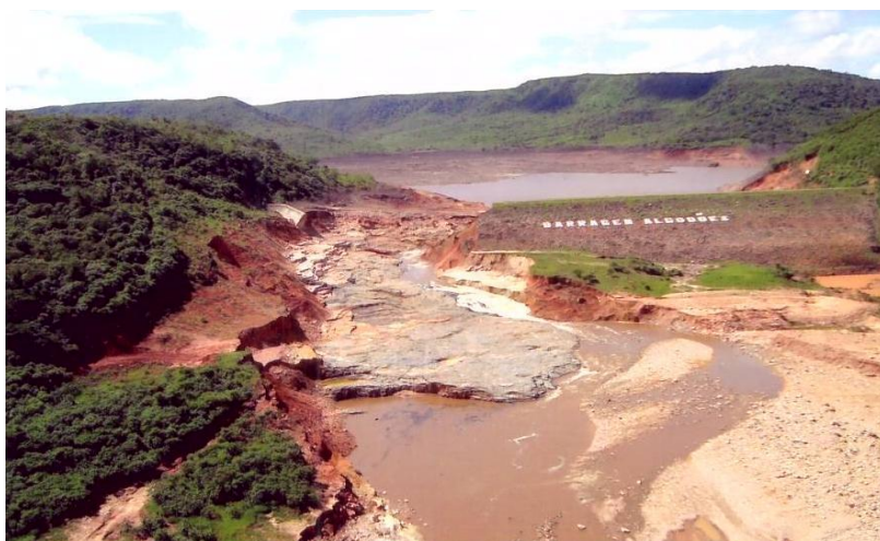
Foto 10 – Barragem Algodões I – vista de jusante, observando-se o rompimento do aterro junto à ombreira direita.
