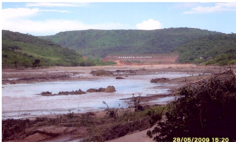
Foto 9 – Barragem Algodões I, vista de jusante, observando-se a erosão do leito e das margens e enorme volume de lama e entulhos.
