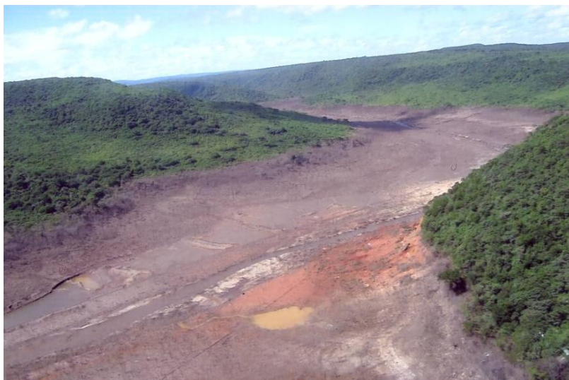
Foto 10 – Barragem Algodões I – vista de jusante, observando-se o rompimento do aterro junto à ombreira direita.
