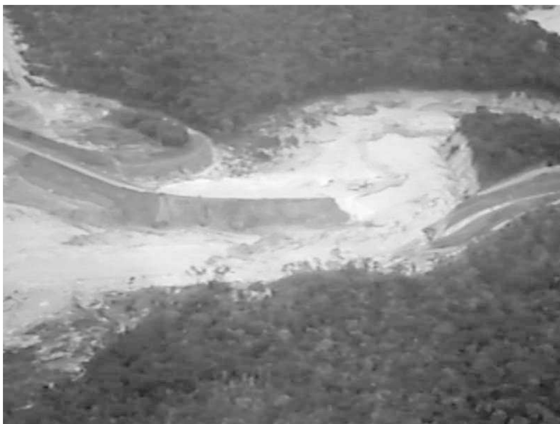
PCH de Apertadinho após o rompimento.
