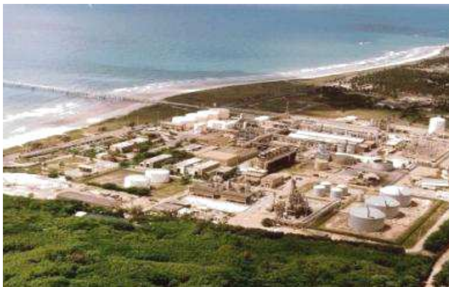
Vista aérea do parque industrial da Braskem em Maceió (AL)
