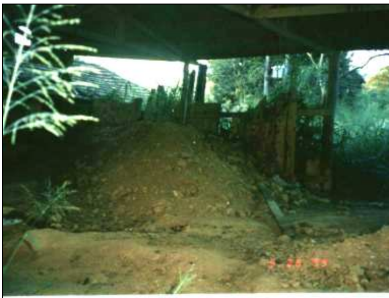
1999: barracão com o amianto (depois foi retirado)
