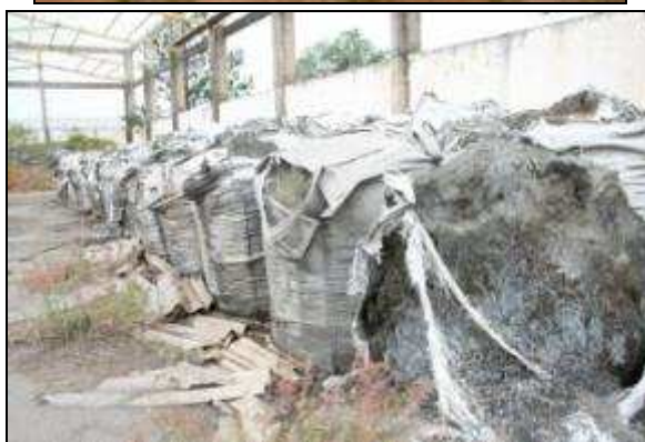
Vista externa do galpão
