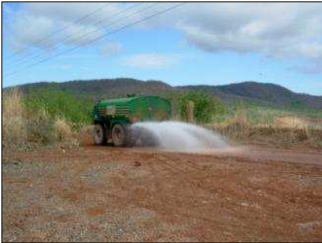
Caminhões lançam água na estrada que liga a mina à indústria
