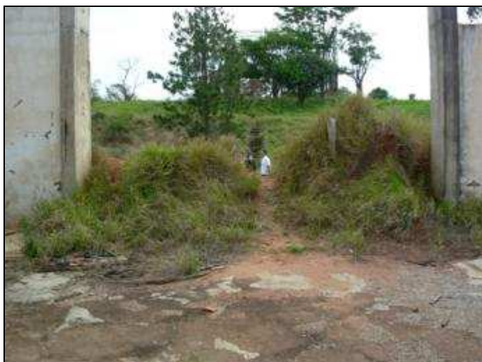
Um dos caminhos de acesso ao galpão
