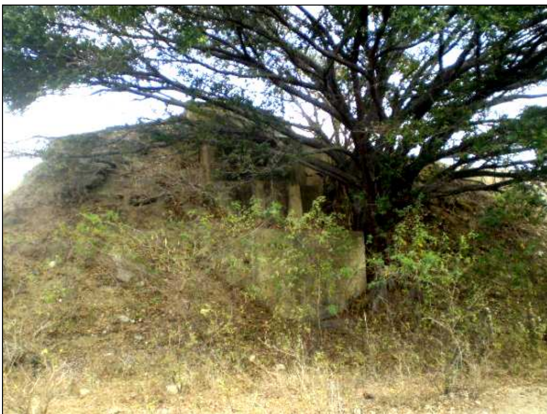
Construções abandonadas pela SAMA
