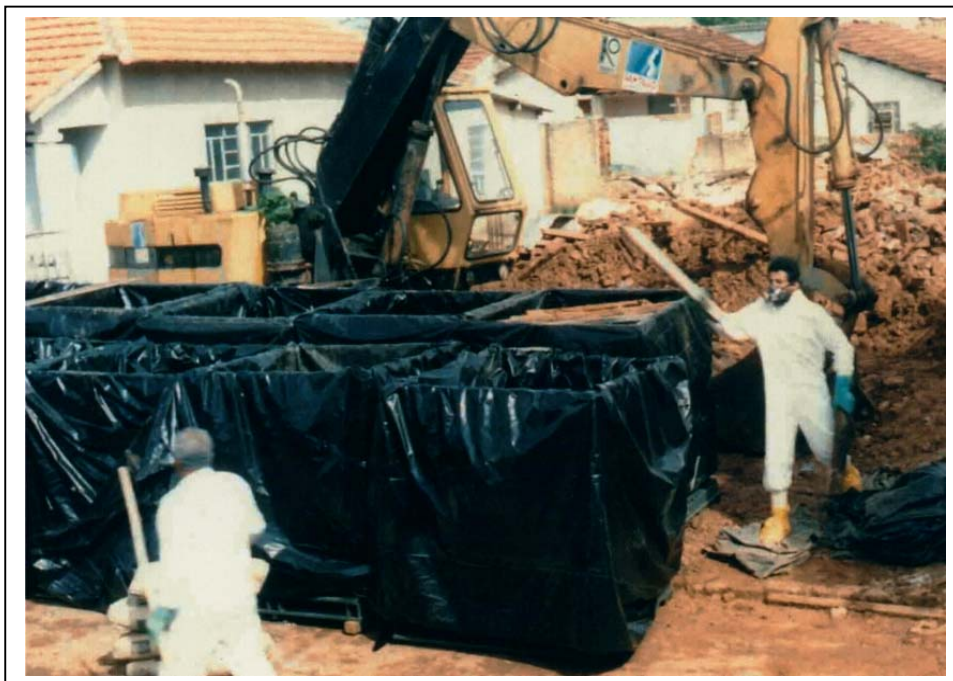
Foto 2 : o material é acondicionado em containers. Os que fazem o serviço estão sem capacete. Atenção para o operador da máquina: com trajas inadequados para a atividade.
