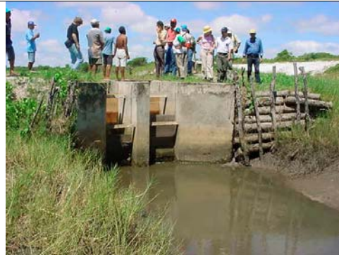
Precariedade das comportas, sem telas eficientes para evitar fugas do camarão.
