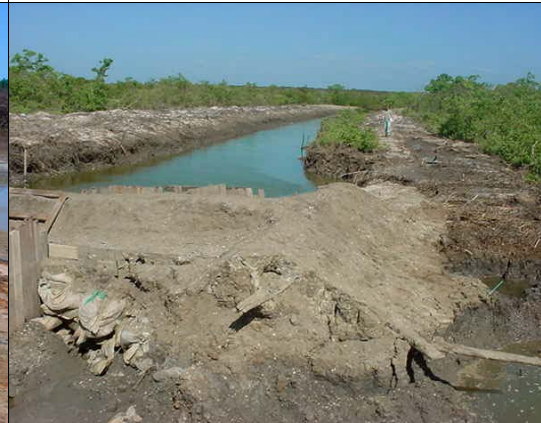
Vista do canal construído em manguezal, com largura de aproximadamente 30 m e comprimento de mais de 100 m.
