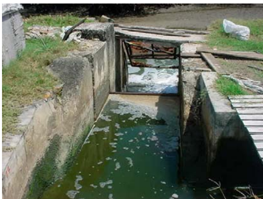
Descarte direto dos efluentes no manguezal, pode levar à contaminação das águas e da vegetação. Não há também um sistema eficiente para evitar fugas do camarão durante a despesca.
