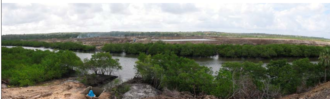
Vista do rio Jundiaí a partir do talude dos tanques do empreendimento. Constatase desmatamento de manguezal, ocupação de APP e adensamento de empreendimentos, como se verifica pela presença de ocupação pela atividade na margem oposta do rio. De acordo com o IDEMA existem na margem direita (oposta) do rio Jundiaí, entre Macaíba e Uruaçu, dezessete empreendimentos instalados.
