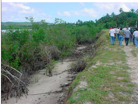
Talude causando assoreamento no manguezal.
