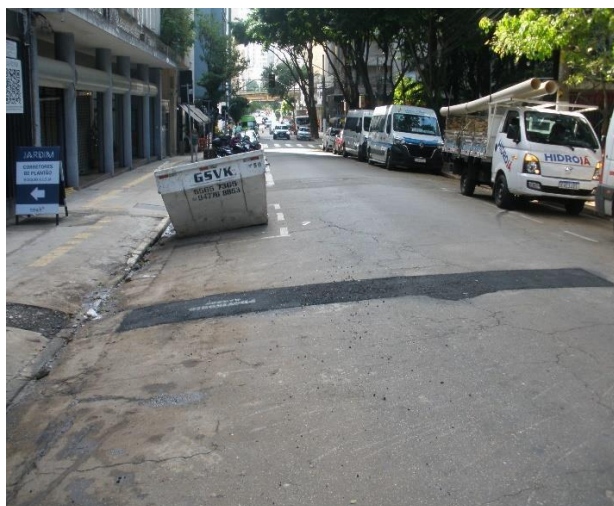
Foto 3: Local de obra da SABESP
