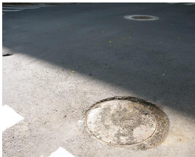
Foto 4: Tampa da câmara subterrânea da ENEL SP
