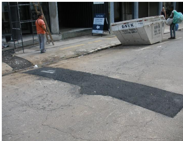
Foto 1: Local de obra da SABESP
