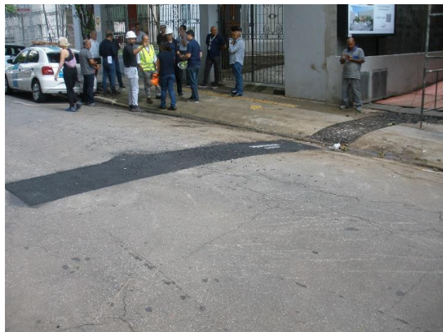
Foto 2: Local de obra da SABESP
