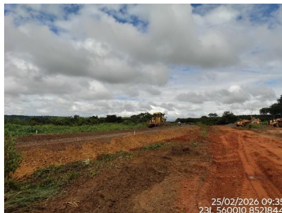
Figura 17 - Execução de sublastro, km 682+820, Lote 6F-A, Coordenadas em Datum SIRGAS 2000.
