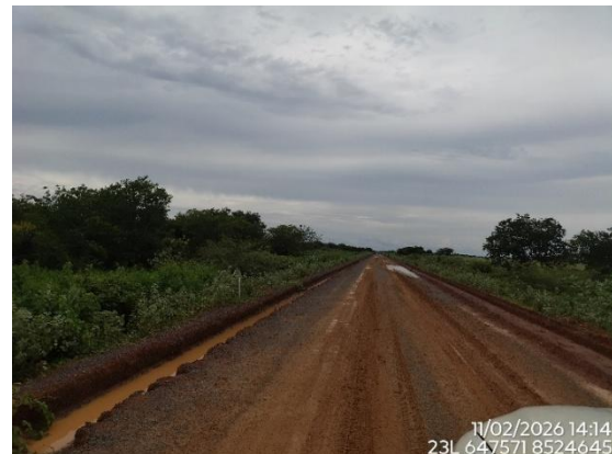
Figura 13 - Execução de obras de drenagem, km 782+300, Lote 6F-A, Coordenadas em Datum SIRGAS 2000.
