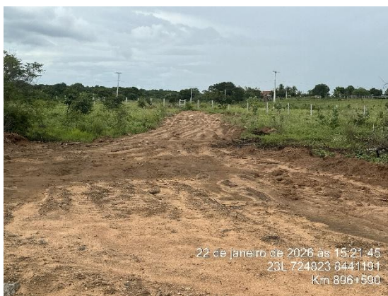
Figura 2 – Abertura de caminho, km 896+590, Lote 5F, Coordenadas em Datum SIRGAS 2000.
