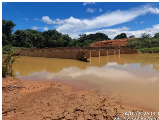
Figura 16 - Acompanhamento do avanço físico da obra, OAC, km 750+890, Lote 6F-A, Coordenadas em Datum SIRGAS 2000.
