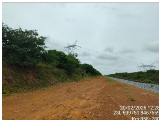
Figura 4 – Limpeza mecanizada de vegetação adjacente à malha ferroviária, no trecho compreendido entre os km 858+750 e km 859+460, Coordenadas em Datum SIRGAS 2000.
