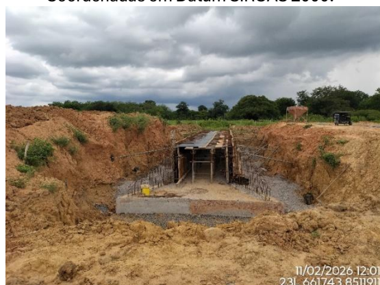
Figura 21 - Execução de obra de arte, km 801+420, Lote 6F-C, Coordenadas em Datum SIRGAS 2000.
