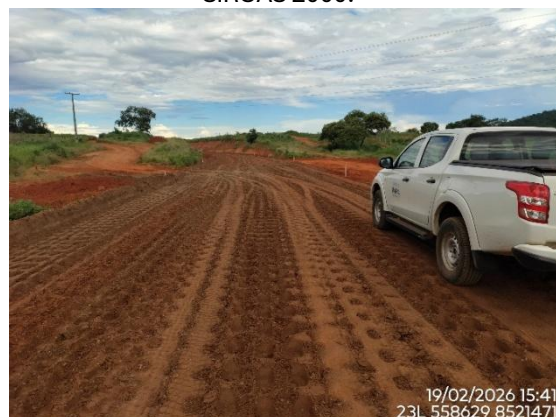
Figura 15 Execução de sublastro, km 681+320, Lote 6F-A, Coordenadas em Datum SIRGAS 2000.
