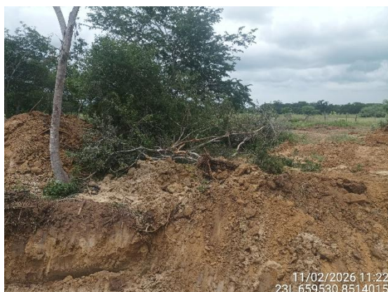
Figura 5 – Remoção de vegetação sem comunicação e acompanhamento da supervisão ambiental, Lote 6F. Coordenadas em Datum SIRGAS 2000.
