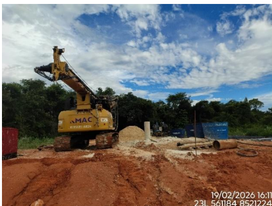
Figura 14 Execução de perfuração de estacas raiz para ponte, km 684+120, Lote 6F-A, Coordenadas em Datum SIRGAS 2000.
