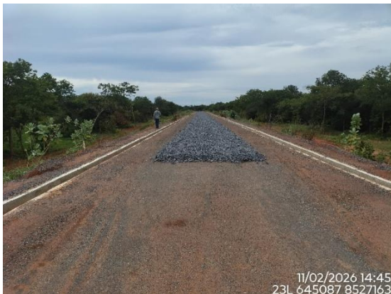
Figura 12 - Execução de lastro, km 778+760, Lote 6F-A, Coordenadas em Datum SIRGAS 2000.
