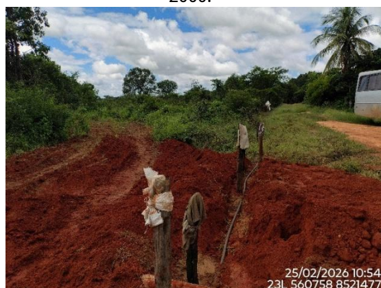
Figura 19 - Área antes de limpeza e destoca com MN, km 683+640 ao 683+800, Lote 6F-A, Coordenadas em Datum SIRGAS 2000.
