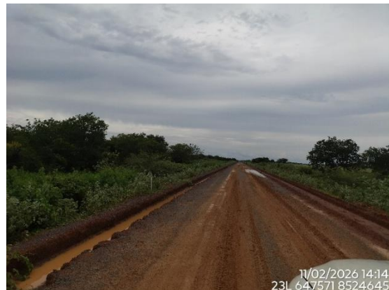
Figura 13 - Execução de obras de drenagem, km 782+300, Lote 6F-A, Coordenadas em Datum SIRGAS 2000.
