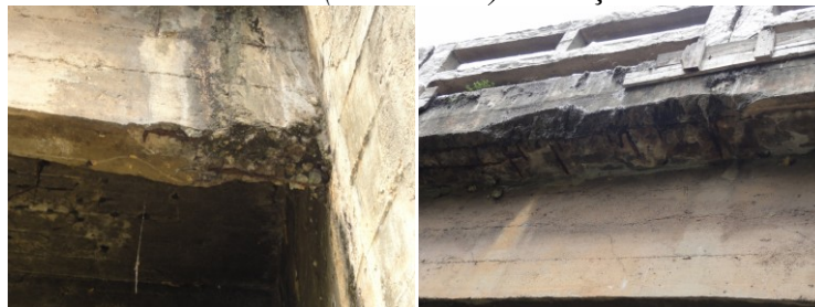
Figura 3 - Ponte sobre o Rio Grande (BR-101/ES): situação em 2011 – Fiscobras
