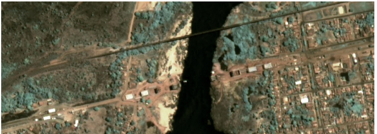
Figura 3: situação da obra de construção da ponte Juscelino Kubitschek (BR-226/TO) em 7/9/2025
