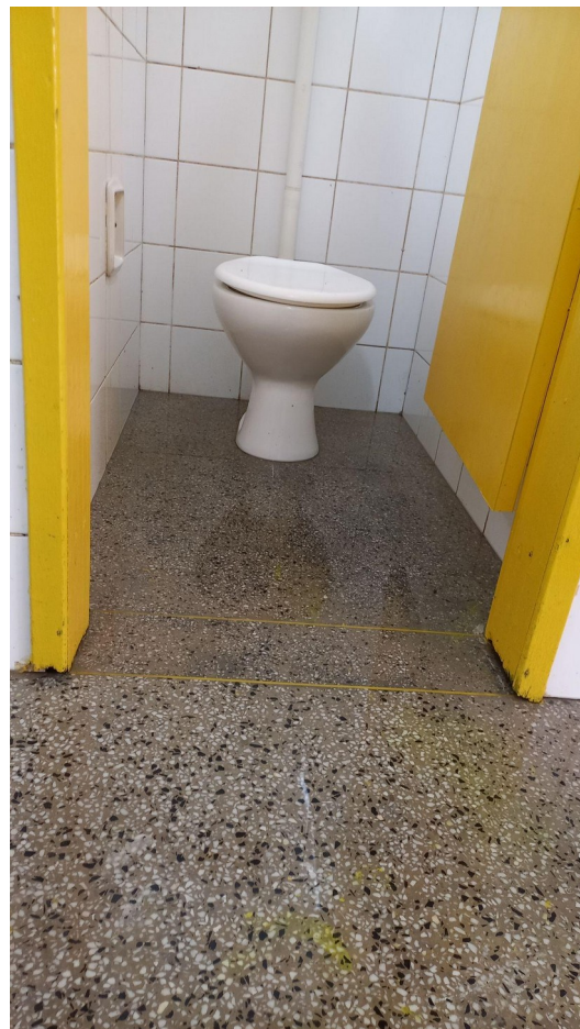
Figura 27 e 28: Instalações sanitárias com problemas de vazamento.
