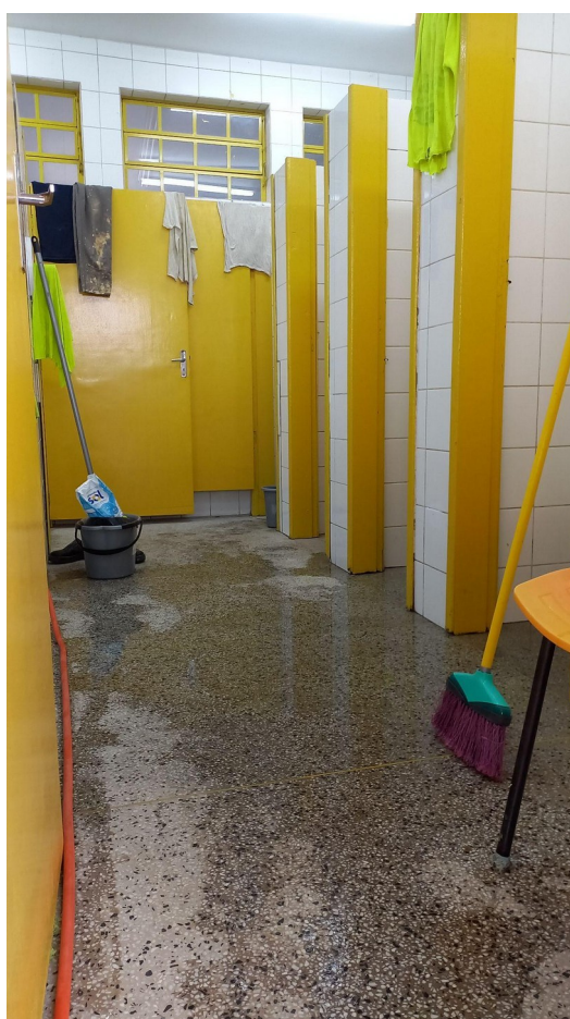
Figura 27 e 28: Instalações sanitárias com problemas de vazamento.
