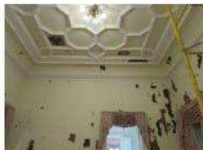
Fig.01: Vista geral, início dos trabalhos Fotos: Imperial Cia de Restauro
