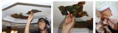
Fig.06 – 07: Intervenções no forro, remoção de repintura
