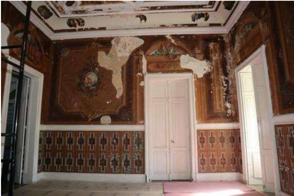
Fig.31 - Vista geral da pintura
