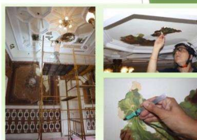
Processo de remoção de camadas de repintura no forro
