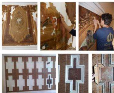
Processo de remoção mecânica de camadas de repintura
