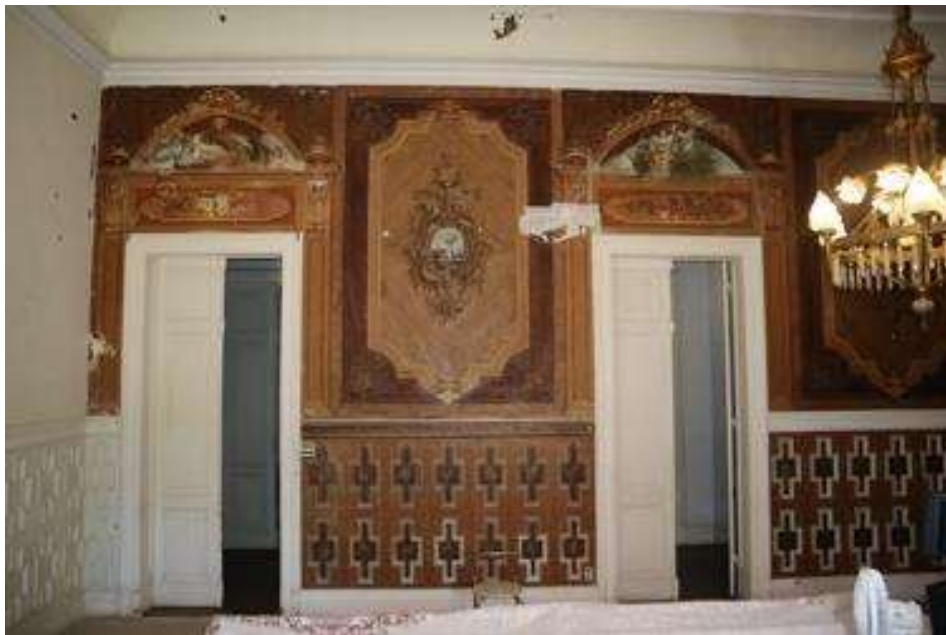
Fig.21-Vista geral da pintura
