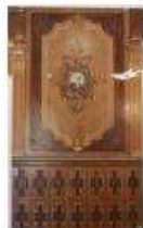
Fig.02: Após remoção de repinturas
