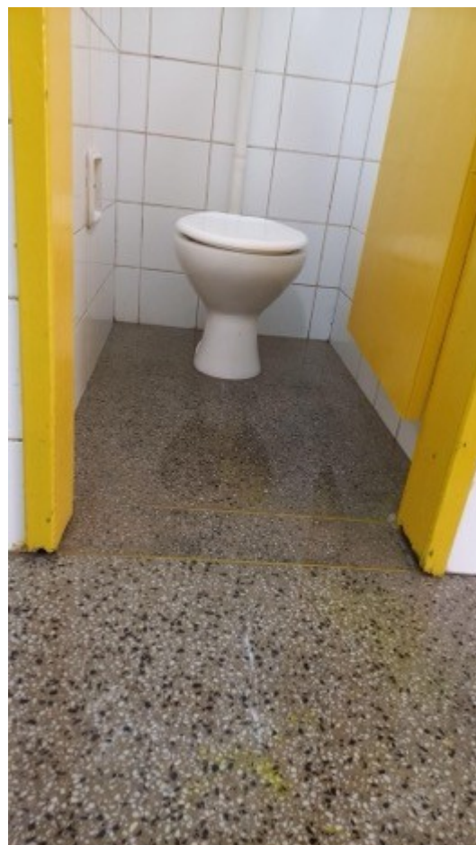
Figura 27 e 28: Instalações sanitárias com problemas de vazamento.
