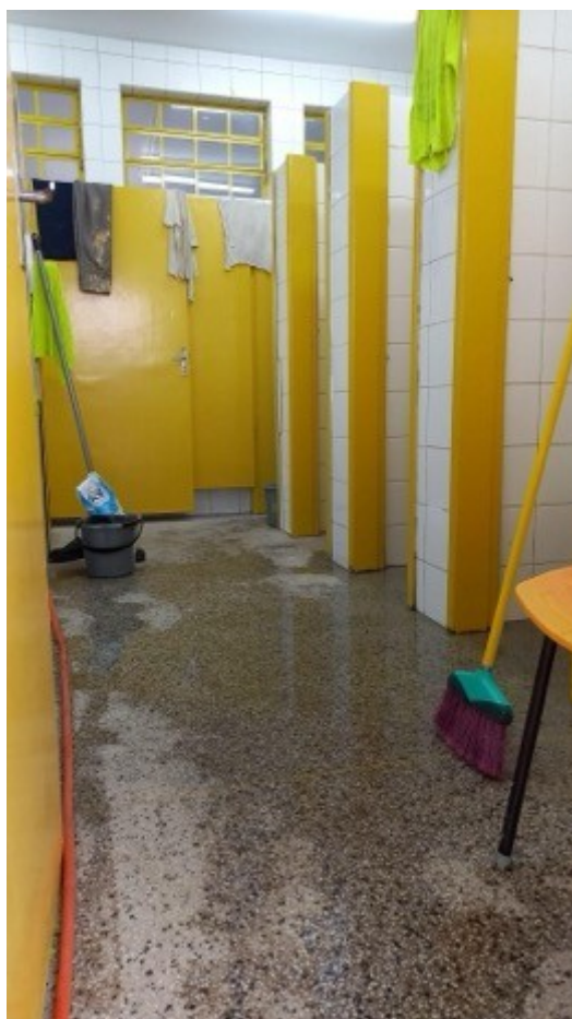
Figura 27 e 28: Instalações sanitárias com problemas de vazamento.
