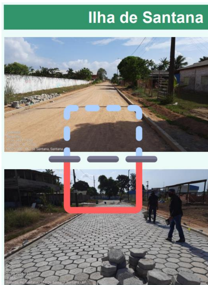
Figura 3 - Antes e depois. Serviços executados em Ilha de Santana-AP
