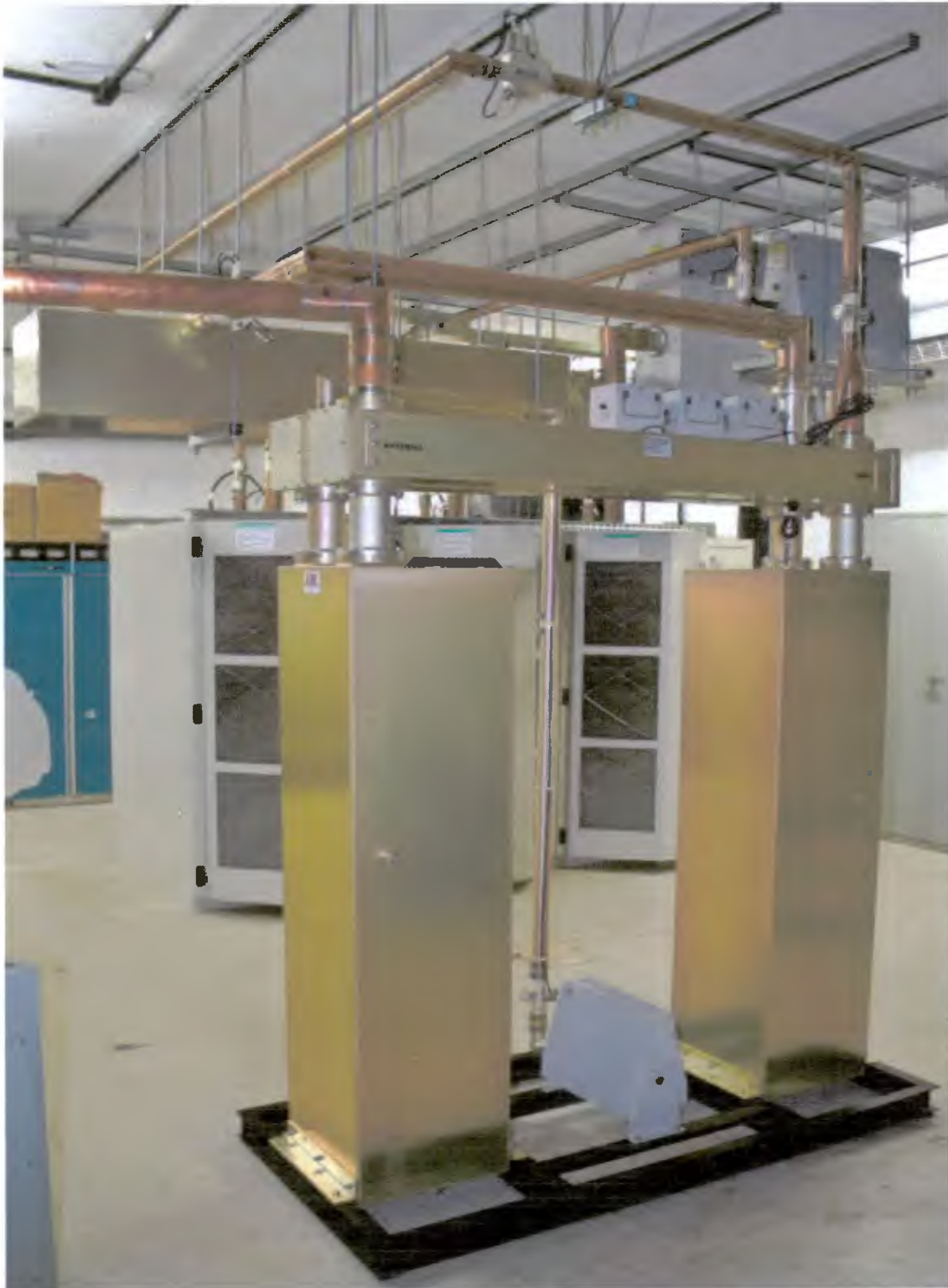
Foto 4 - Vista da Parte Traseira do Equipamento mostrando as interligações das diversas unidades, a Saída de R.F. e as cargas de rejeição.
