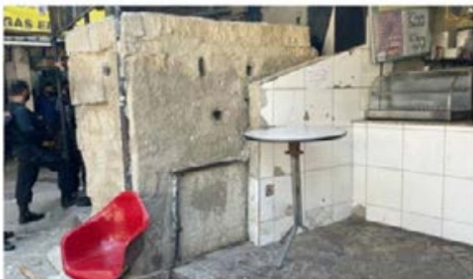
A imagem acima mostra uma construção de alvenaria usada como fortificação para proteger uma barricada instalada na entrada da comunidade.
