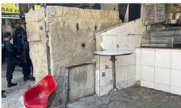
A imagem acima mostra uma construção de alvenaria usada como fortificação para proteger uma barricada instalada na entrada da comunidade.
