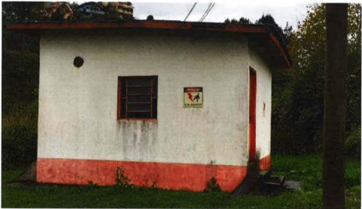
Abrigo do Transmissor com aviso de Perigo
