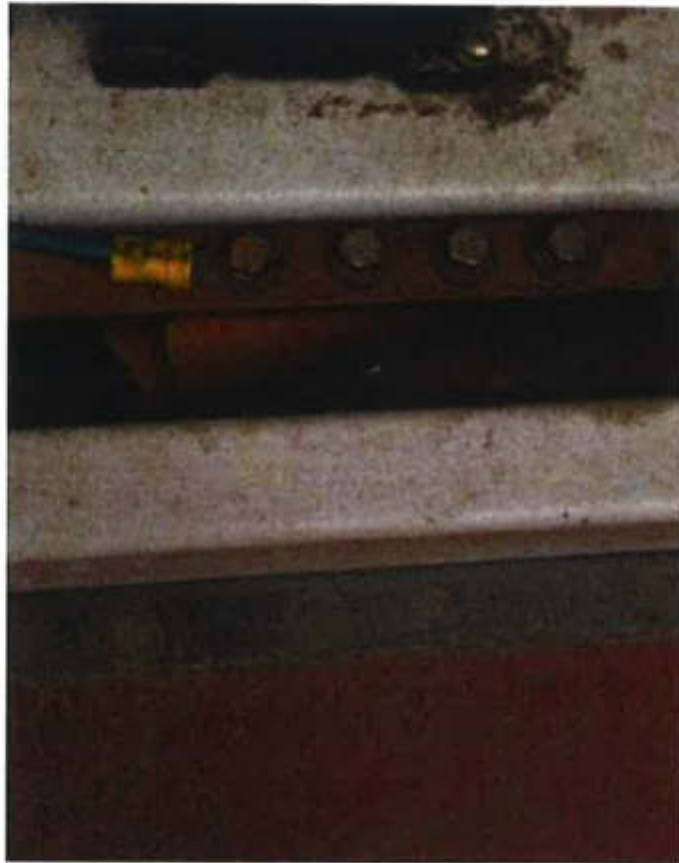
Detalhe do Aterramento na base do Transmissor instalado na parte traseira
