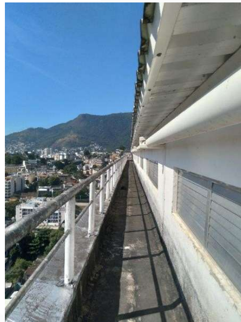
Fig. 6 e 7 - Impermeabilização da laje (parte externa) danificada
