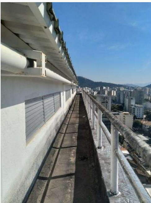
Fig. 6 e 7 - Impermeabilização da laje (parte externa) danificada
