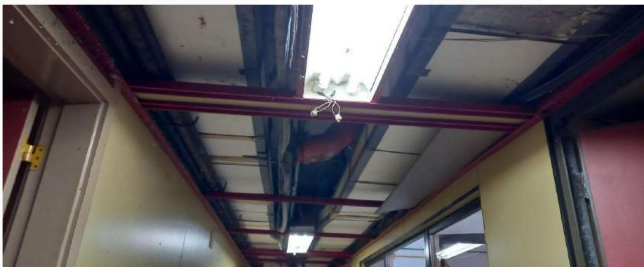
Fig. 29, 30 e 31 – Vistas do 4º Pavimento fechado.
