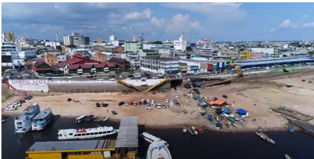
Porto Organizado de Manaus. Rampas e cais (Roadway) flutuantes adaptados ao nível do Rio Negro em período de seca.
