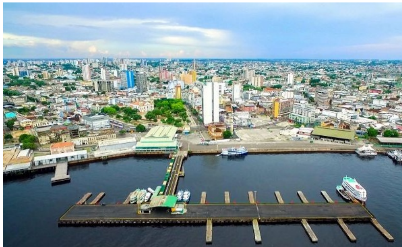
Porto Organizado de Manaus. Cais flutuante do Roadway, fingers (pequenos flutuantes móveis utilizados para embarque e desembarque de passageiros e cargas) e rampa flutuante.
