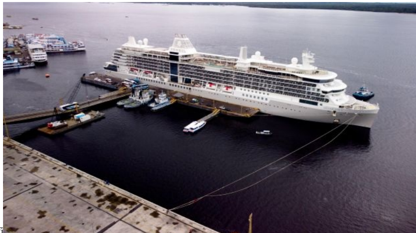
Porto Organizado de Manaus, rampa flutuante de acesso a navio de cruzeiro no Cais das Torres, bem como os fingers flutuantes, em uso por embarcações menores.
