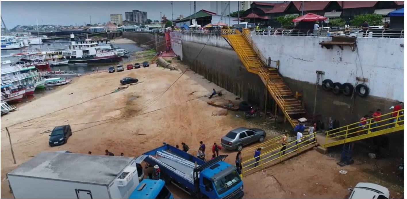
Cais da Manaus Moderna. Rampas flutuantes balsas e rampas flutuantes utilizadas em periodos de seca.
