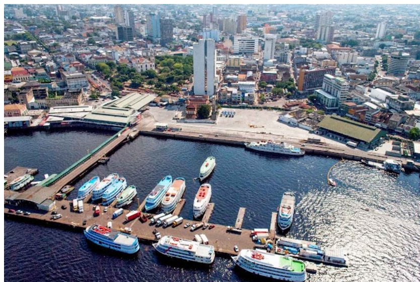
Porto Organizado de Manaus. Rampas e cais (Roadway) flutuantes em época de cheia. Percebe-se o cais e a rampa no mesmo nível da margem.
