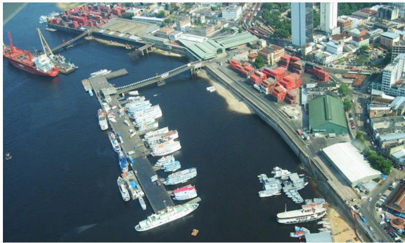
Porto Organizado de Manaus, rampas flutuantes de acesso aos cais (das Torres e Roadway) flutuantes em época de seca. Percebe-se a adaptação das rampas ao nível mais baixo do Rio Negro.
