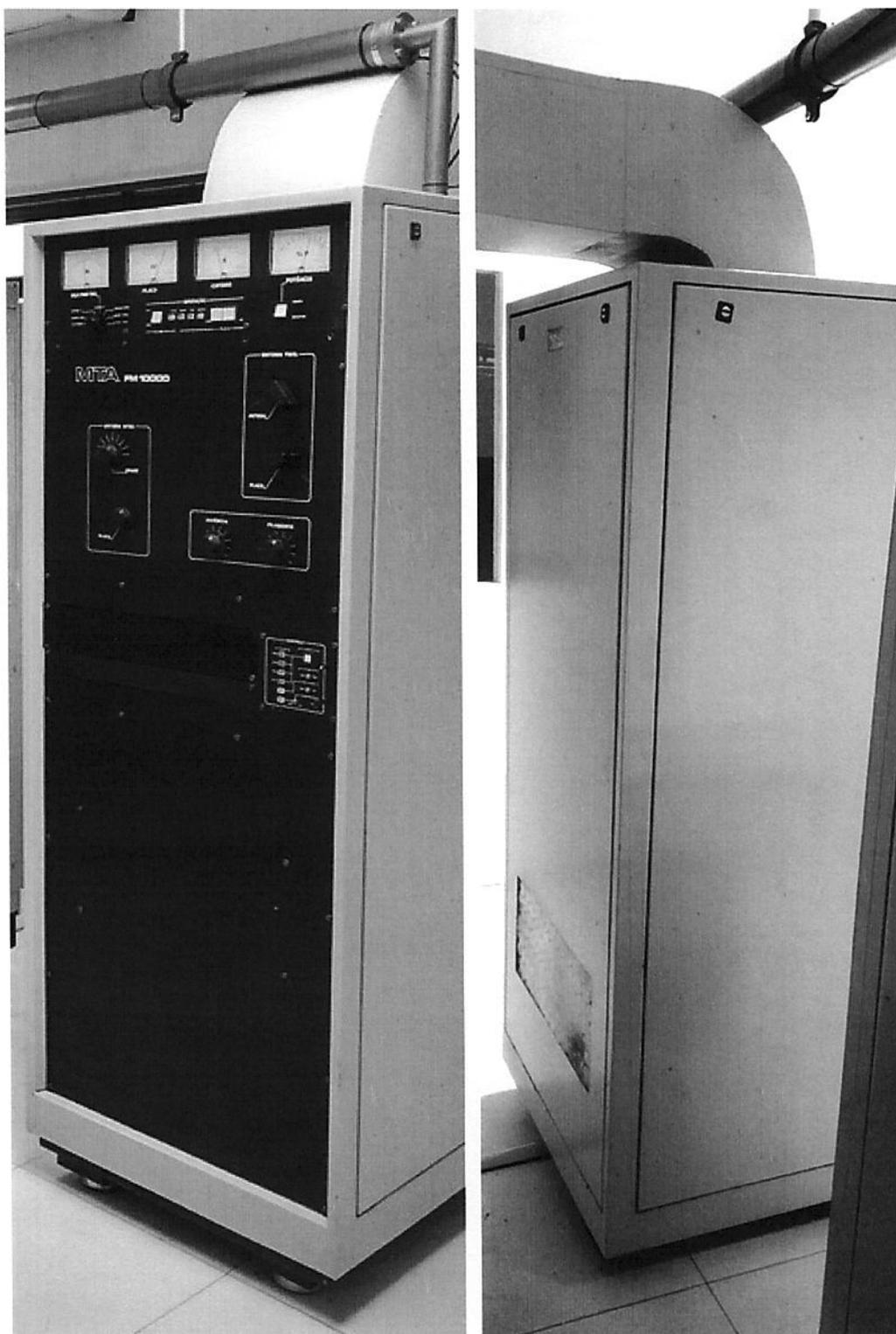
Figura 8 - Rack Transmissor vista frontal e traseira
