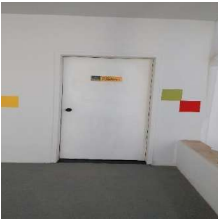
Figura 6 BANHEIRO FEMININO INTERNO
