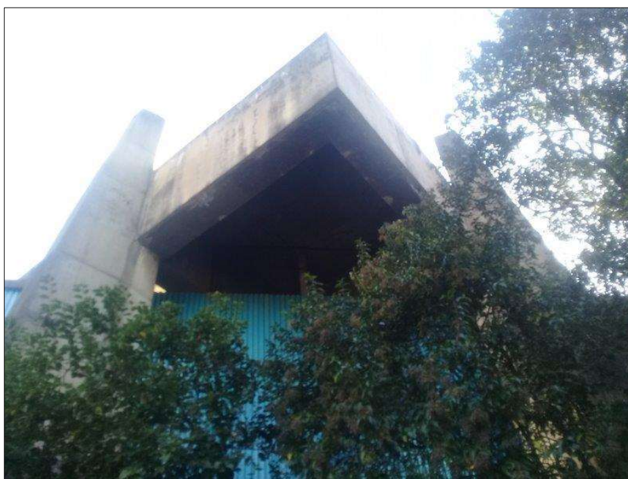
Figura 37 - Ginásio Mauro Pinheiro, 2023. Detalhe da laje em balanço (Iphan)
