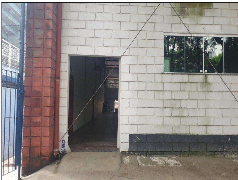
Figura 3: tirante interferindo nas aberturas do Palácio do Judô (IPHAN)
