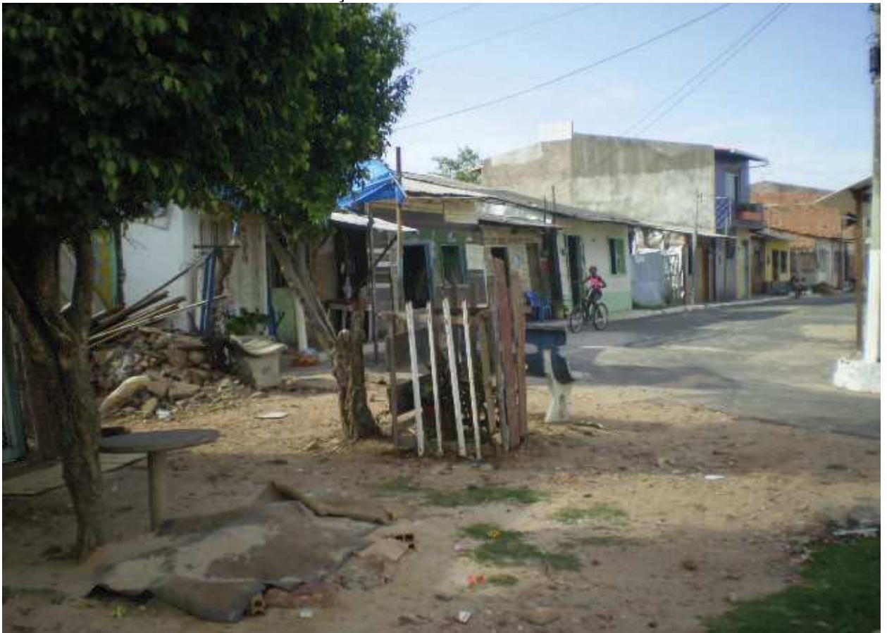
FOTO Nº 02 – LIMITE ENTRE A ÁREA INVADIDA E A OCUPAÇÃO ANTIGA
