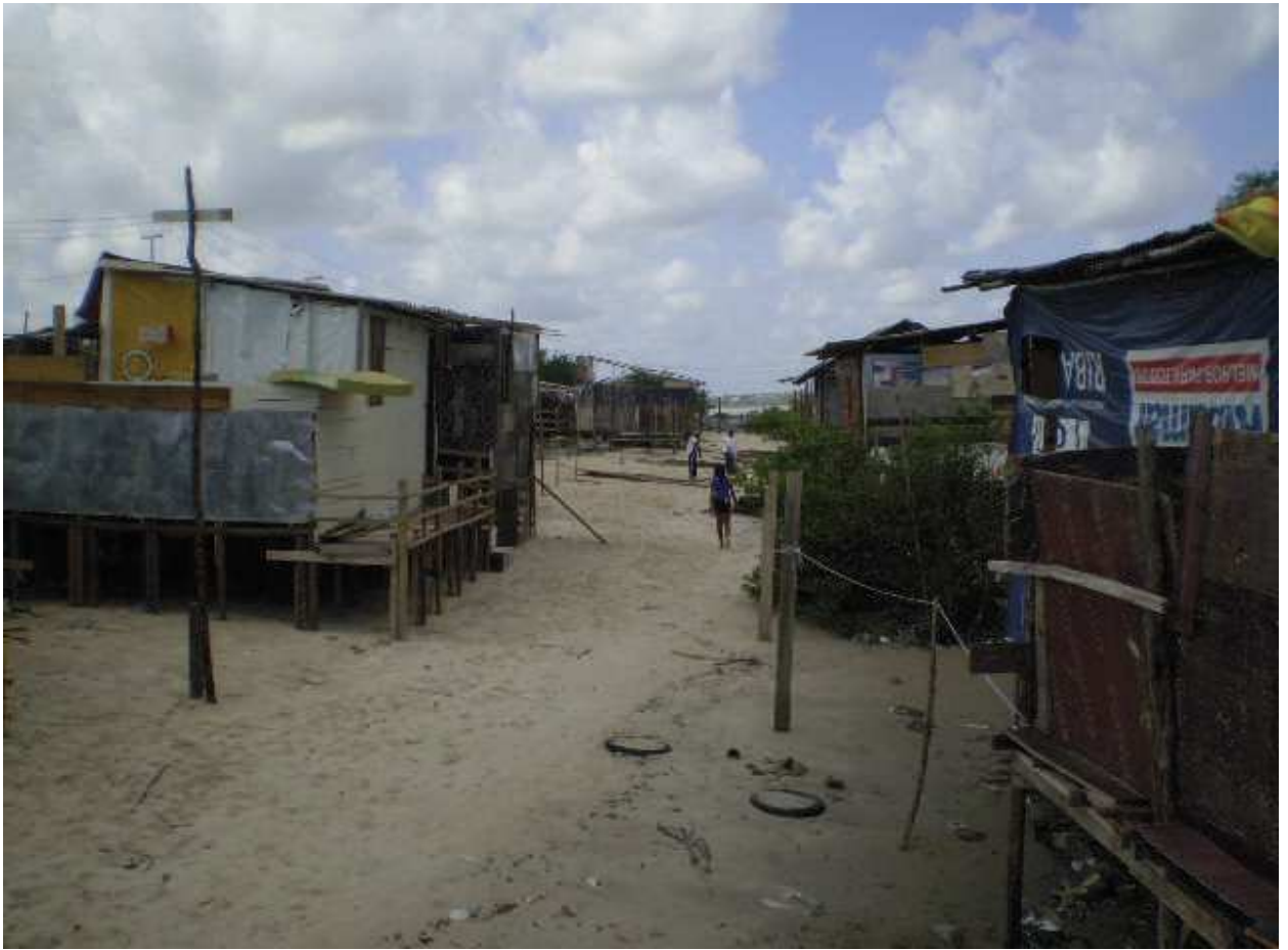
FOT 03 – VISÃO GERAL DA OCUPAÇÃO IRREGULAR NA ILHINHA
