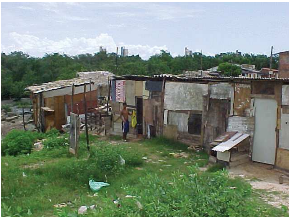
FOTO 08 – ASPECTO DE FALTA DE ORGANIZAÇÃO E CASEBRES RÚSTICOS QUE DEVEM SER DEMOLIDOS
