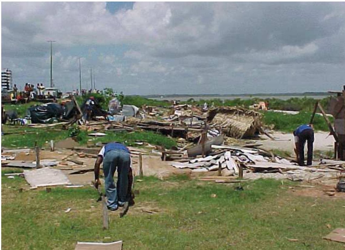
FOTO 07 – INVASÃO TOTALMENTE DERRUBADA E MATERIAL RETIRADO
