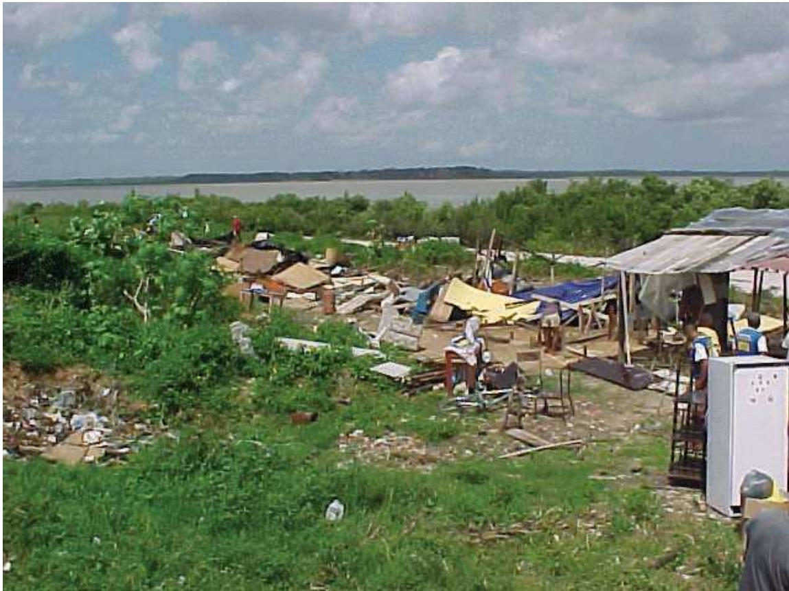
FOTO 05 – ALGUMAS EDIFICAÇÕES DERRUBADAS
