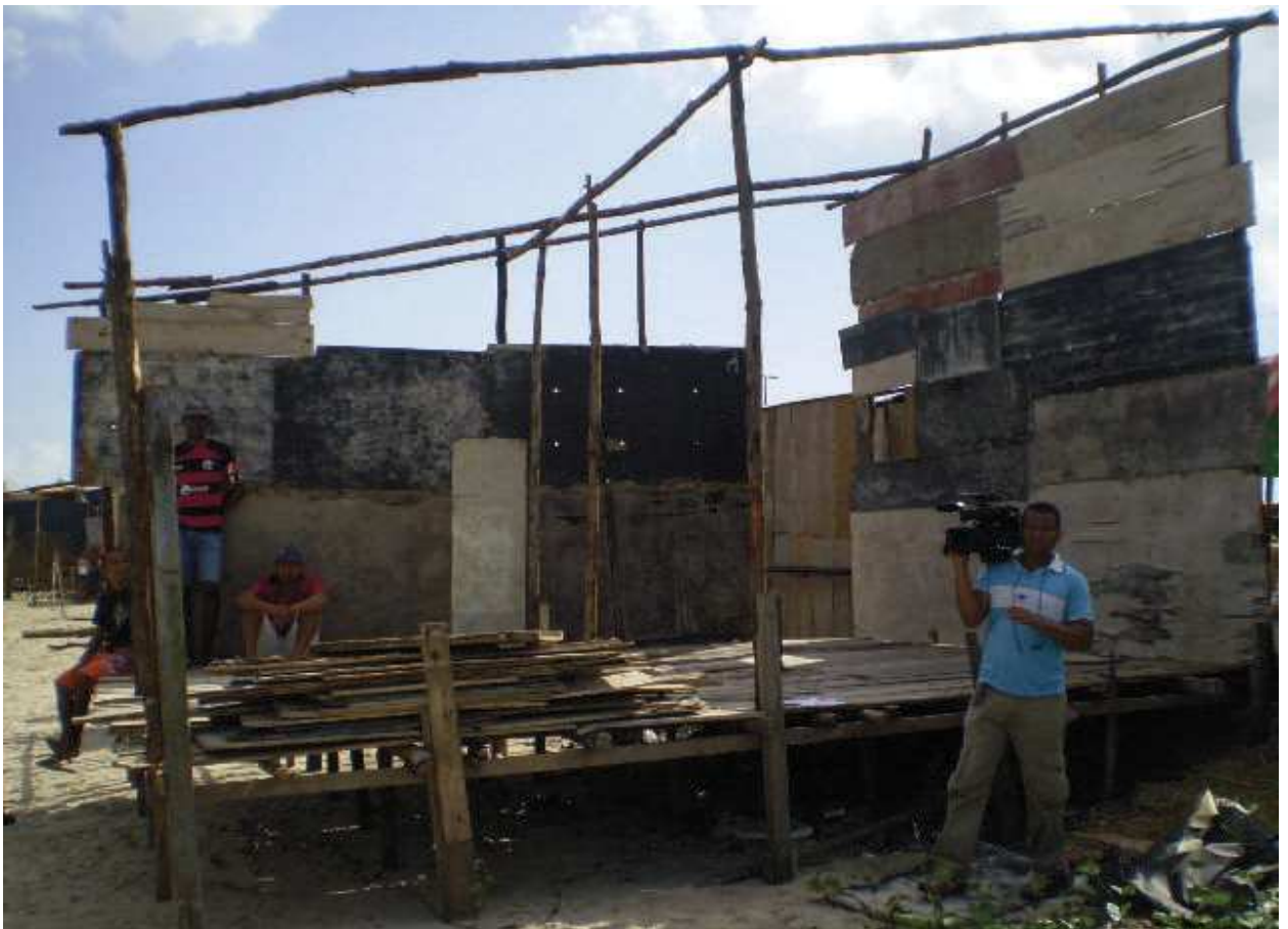
FOTO 08 – CASEBRE SENDO DEMOLIDO PELOS PRÓPRIO INVASOR DA ÁREA
