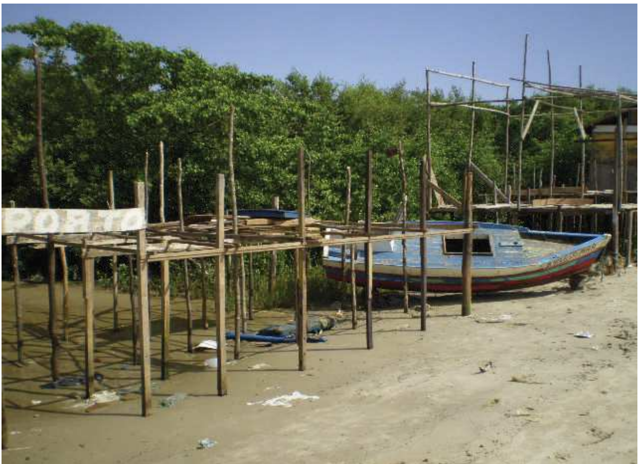
FOTO 06 – DETALHE DAS ARMAÇÕES EM FASE INICIAL
