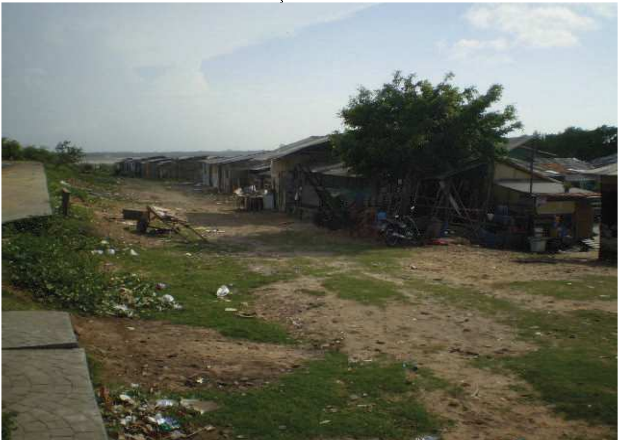
FOTO 08 – DETALHE DA GRANDE QUANTIDADE DE CASEBRES ÀS MAGENS DA AVENIDA
