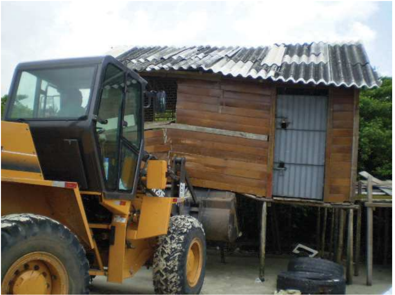
FOTO 07 – DEMOLIÇÃO DE UMA DAS PALAFITAS QUE ESTAVA SEM MORADOR
