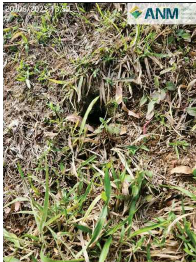
Figura 3.4 – Buracos de animais no talude de jusante
