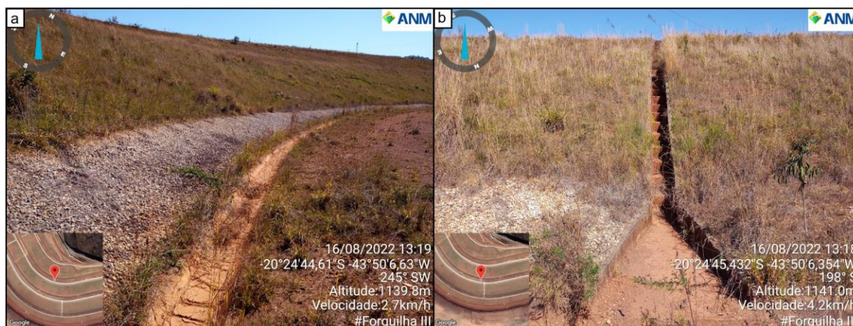
Figura 35. Saída de drenagem interna na segunda berma e escada hidráulica do talude superior em boas condições estruturais.
