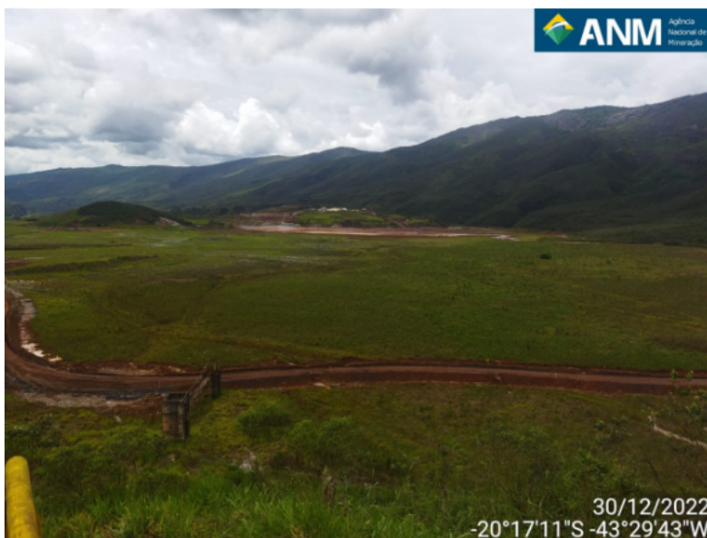
Figura 13 - Reservatório da Barragem Doutor. A lâmina de água contida no reservatório de concentra próxima ao sistema de vertimento da estrutura. Ao fundo da imagem também é possível visualizar o limite da bacia hidrográfica do córrego água suja, região íngreme com alta altitude e baixo tempo de concentração.
