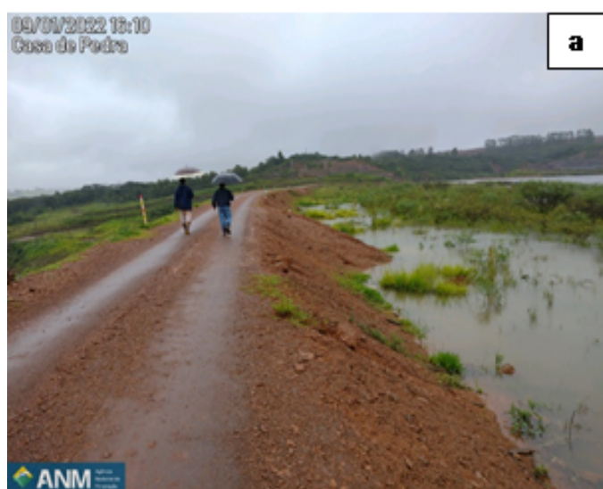
Figura 5. a) Crista da Barragem Casa de Pedra e talude de montante com borda livre; e b) visão do reservatório de Casa de Pedra com acúmulo de água devido às intensas chuvas.
