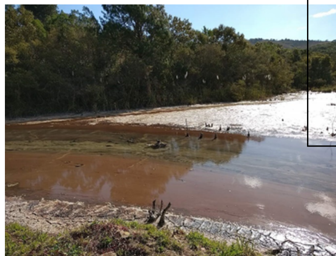
Foto 16: Dique D3, também se encontra assoreado. Fluxo de água ácida decorrente de surgência proveniente do Bota-fora 8. Vegetação ao fundo afetada pela drenagem ácida.
