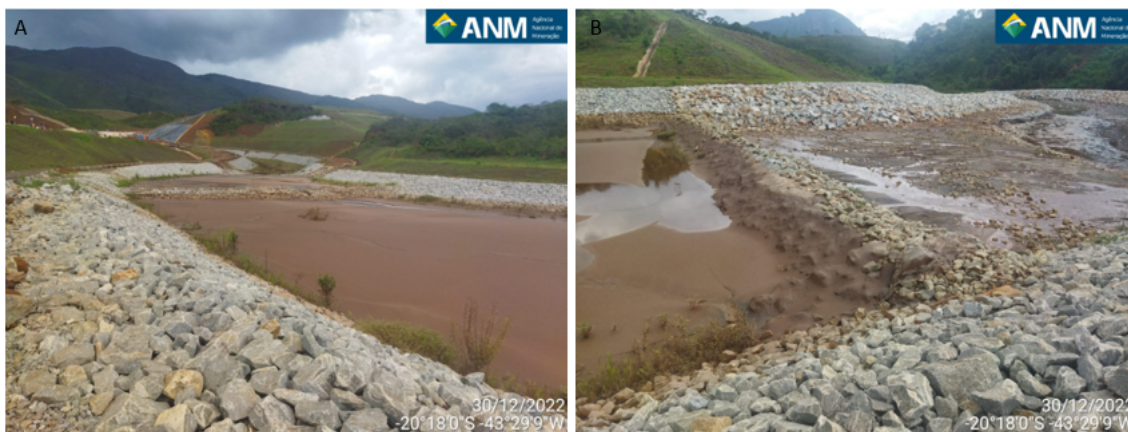
Figura 22 - (A) Proteção de enrocamento no desemboque do canal extravasor para contenção de sedimentos; (B) Última proteção no fim do desemboque. É possível visualizar que o enrocamento encontra-se preservado e não há indícios de vertimento, não havendo marcas de lama na porção a jusante do enrocamento. Ao fundo da imagem é o ponto de confluência entre o córrego e o canal extravasor.
