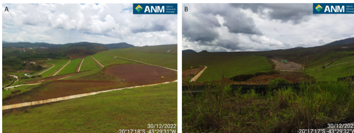
Figura 12 - (A) Imagem do talude de jusante do maciço principal da Barragem Doutor; (B) Erosão presente no contato do talude de jusante com o terreno natural.
