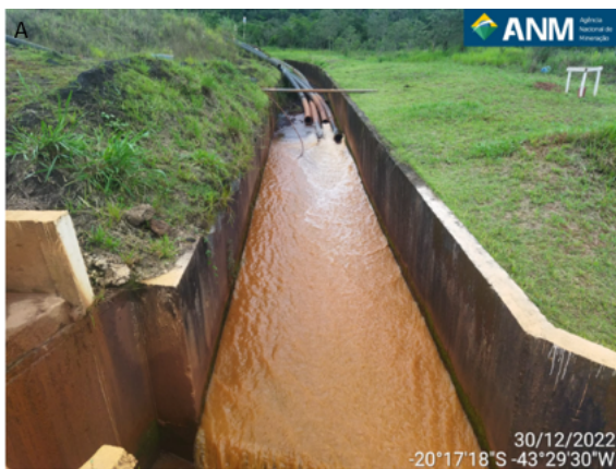
Figura 19 - (A) Localização da tubulação onde ocorre a saída de água redirecionada do reservatório no canal de drenagem superficial; (B) Canal de drenagem que direciona a água até o sump.
