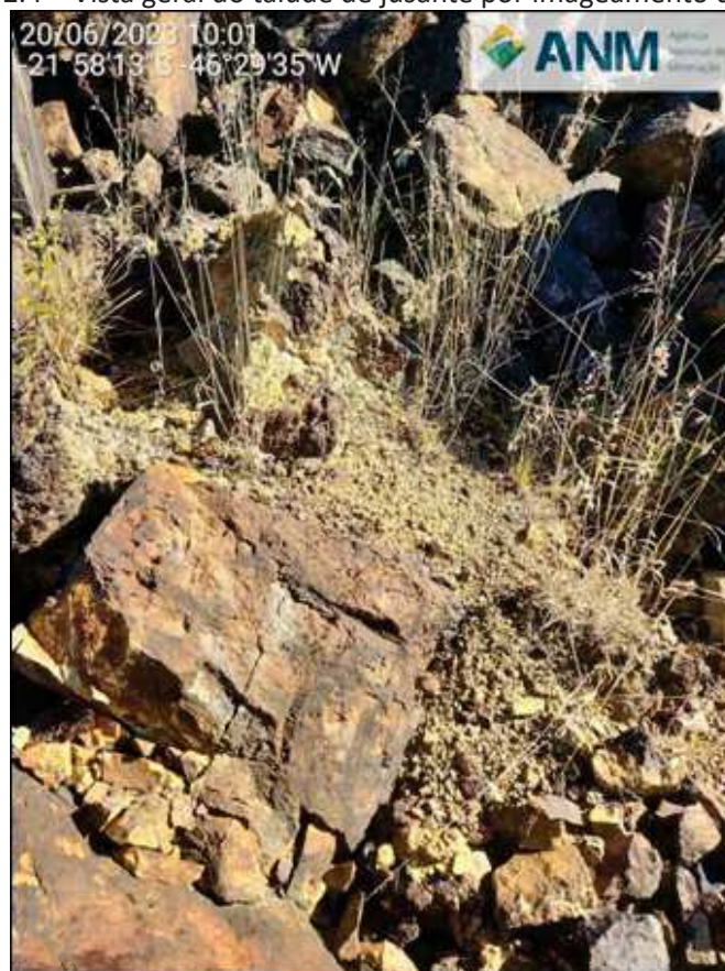
Figura 2.5 – Degradação do enrocamento no espaldar de jusante
