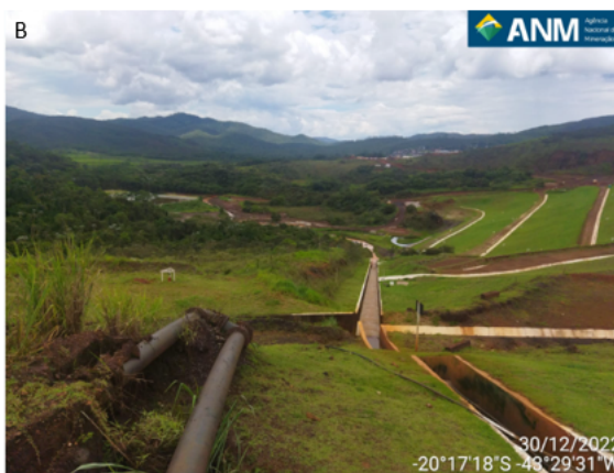
Figura 19 - (A) Localização da tubulação onde ocorre a saída de água redirecionada do reservatório no canal de drenagem superficial; (B) Canal de drenagem que direciona a água até o sump.
