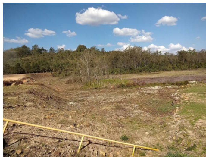
Foto 18: Vista da crista do Dique D3 e da porção completamente assoreada da Barragem D4.
