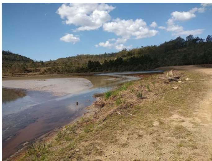
Foto 15: Dique D3, também se encontra assoreado. Fluxo de água ácida decorrente de surgência proveniente do Bota-fora 8.
