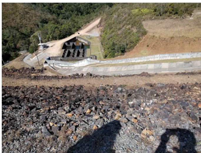
Foto 07: Escada hidráulica do sistema extravasor e o canal de drenagem de águas superficiais. Ao fundo encontra-se o sistema de chicanas onde é adicionado cloreto de bário ao efluente para precipitação de rádio nas Bacias D1 e D2.
