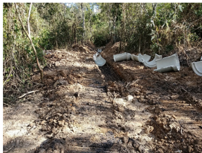
Foto 20: Construção de canal de desvio do efluente tratado na ETE da Barragem D4 (BIA, D3 e D4). O canal desemboca no Córrego do Bota-fora 8.
