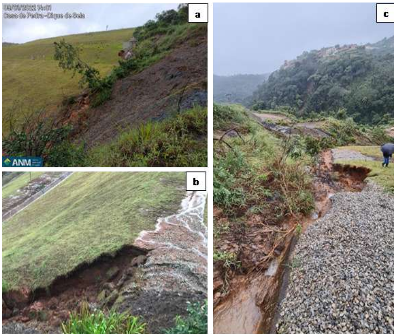
Figura 3. a) escorregamento na ombreira esquerda que obstruiu canaletas de drenagem pluvial do Dique de Sela; b e c) canaletas obstruídas e erosão no maciço do Dique de Sela.
