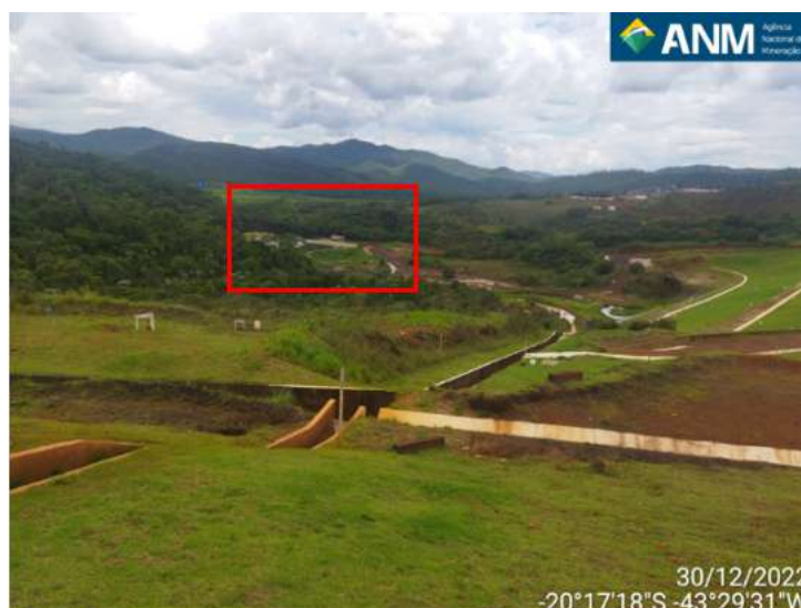
Figura 20 - Destaque em vermelho para a localização do sump, onde a água proveniente do reservatório adquire tempo de residência para decantação dos sedimentos e depois segue o curso natural de água.
