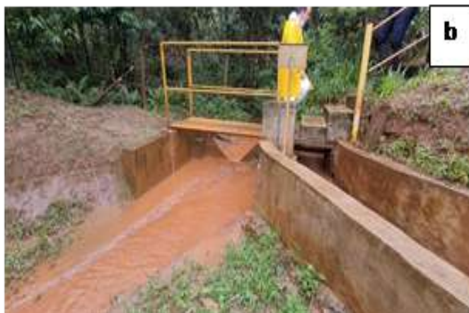
Figura 4. a) Canaleta obstruída desviando a água pluvial em direção ao dreno de pé; e b) medidor de vazão do dreno de pé do Dique de Sela, com incremento de vazão e turbidez da água pluvial desviada.
