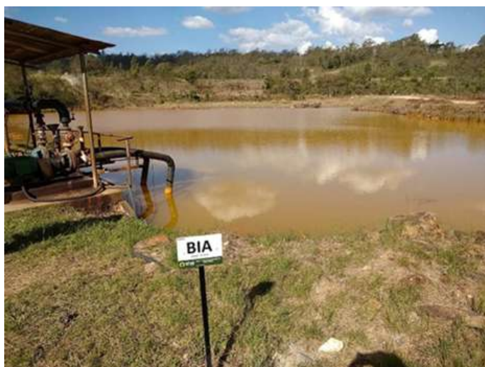
Foto 19: Bacia Ivan Antunes – BIA, onde ocorre a captação de água do Bota-fora 8. Parte significativa da drenagem ácida do Bota-fora 8.
