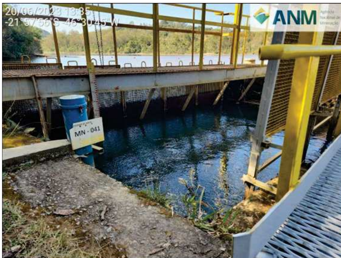
Figura 3.2 – Colmatação da tela de contenção de sedimentos no emboque do sistema extravasor
