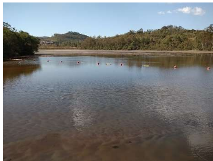
Foto 08: Vista a jusante da Barragem de Rejeitos. Na porção inferior do barramento, há o represamento e coleta por bombeamento da água ácida que percola da Barragem de Rejeitos. Ao fundo, é possível visualizar as Bacias D1 e D2.
