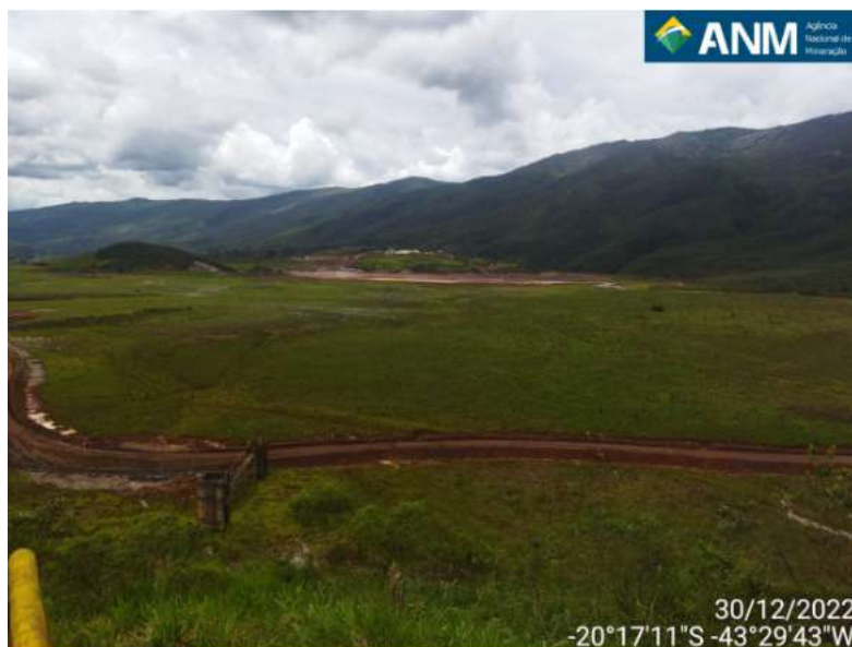
Figura 13 - Reservatório da Barragem Doutor. A lâmina de água contida no reservatório de concentra próxima ao sistema de vertimento da estrutura. Ao fundo da imagem também é possível visualizar o limite da bacia hidrográfica do córrego água suja, região íngreme com alta altitude e baixo tempo de concentração.
