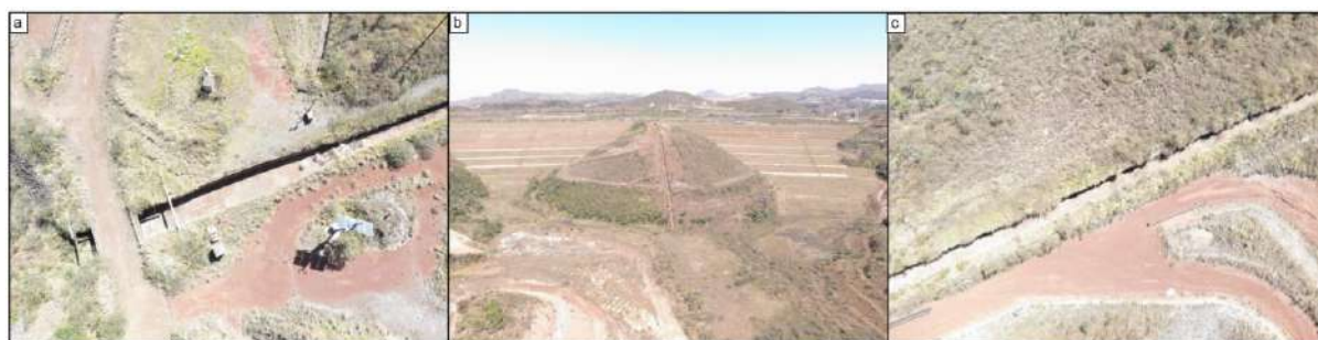
Figura 23. Canal extravasor. (a) vista em planta da região imediatamente a jusante do emboque; (b) vista frontal, com Forquilha II à esquerda, e Forquilha I à direita; (c) trecho adjacente ao acesso da ombreira esquerda.
