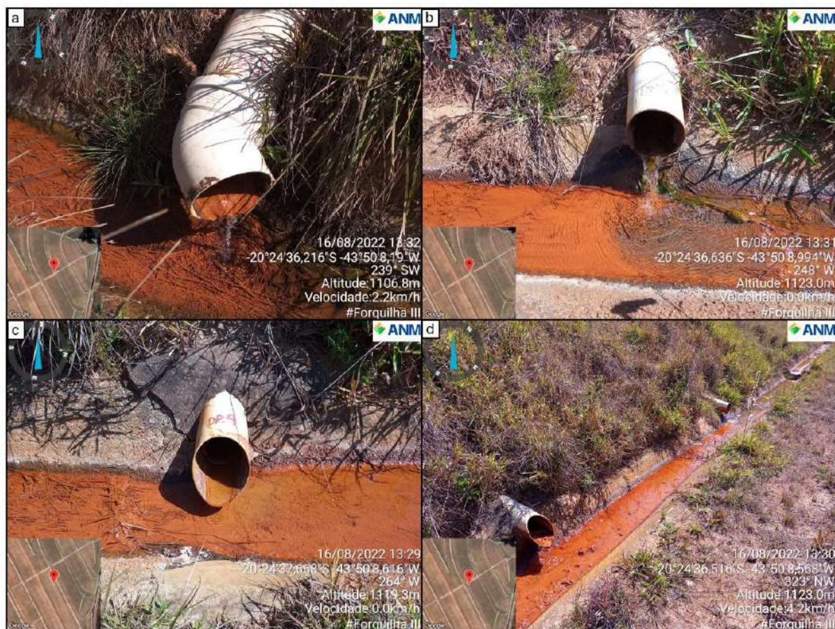
Figura 33.Drenos horizontais com fluxo de água, sem sedimentos aparentes, na terceira berma.
