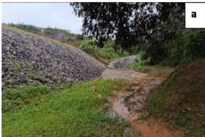
Figura 4. a) Canaleta obstruída desviando a água pluvial em direção ao dreno de pé; e b) medidor de vazão do dreno de pé do Dique de Sela, com incremento de vazão e turbidez da água pluvial desviada.
