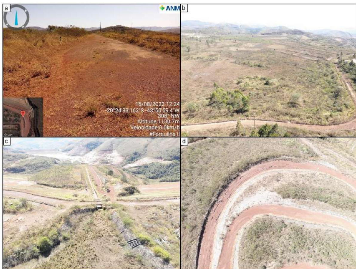
Figura 22. Crista (a), reservatório sem acúmulo de água superficial (b) e emboque do extravasor (c) das Forquilhas I e II. Feições erosivas identificadas nos acessos da ombreira esquerda.
