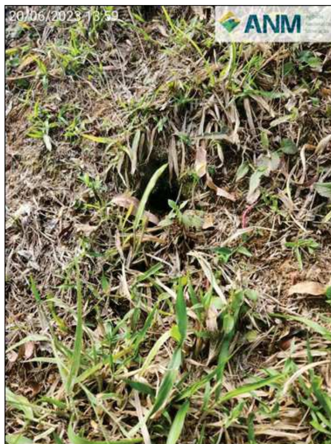
Figura 3.4 – Buracos de animais no talude de jusante
