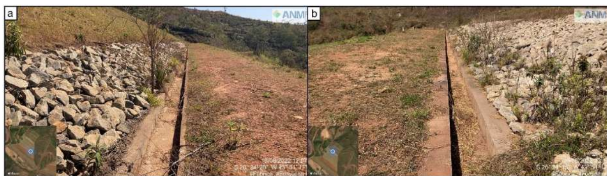
Figura 20. Trechos com enrocamento (saídas de drenagem interna) secos.
