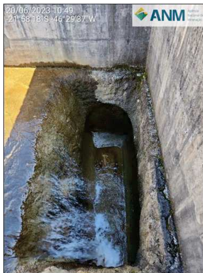
Figura 2.7 – Desemboque tamponado do sistema extravasor desativado
