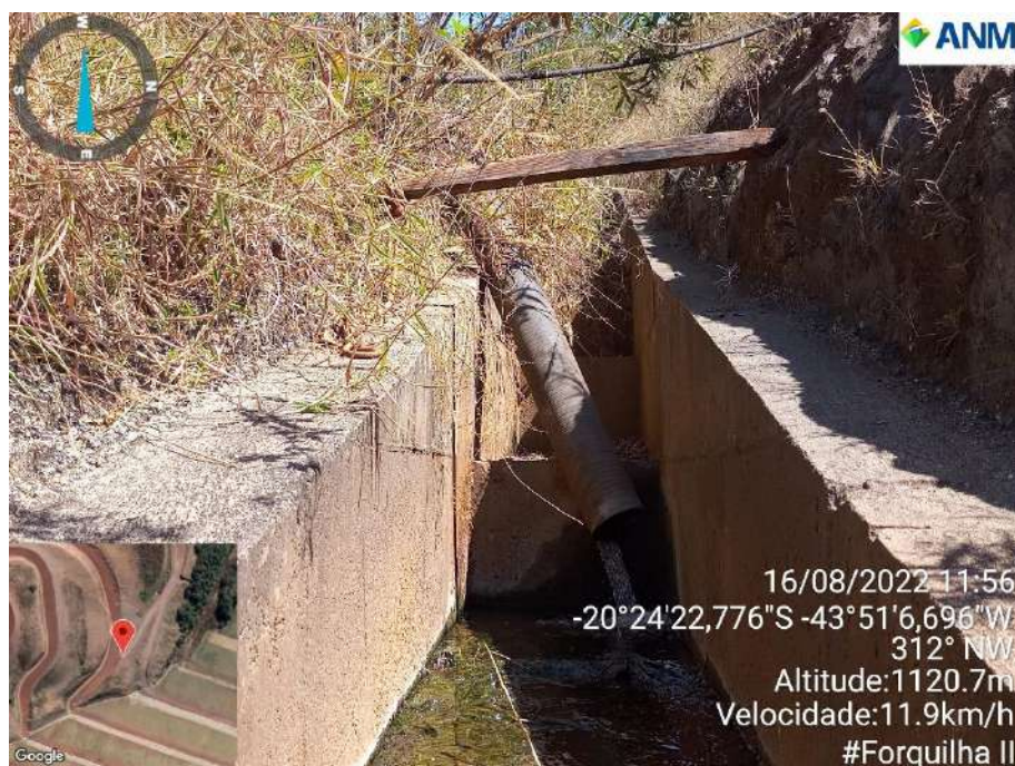
Figura 26- Saída de dreno interno identificado em escada hidráulica situada na ombreira esquerda
