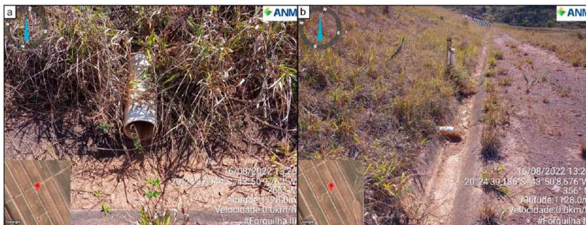
Figura 32. Saídas de drenos horizontais (sem fluxo de água).
