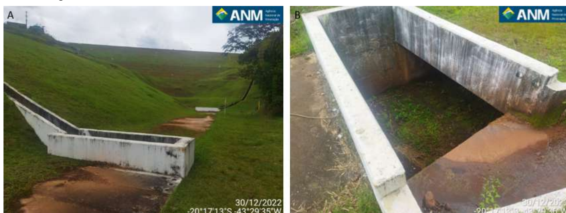
Figura 21 - (A) Túnel do antigo canal extravasor presente na estrutura; (B) Ausência de passagem de água, onde a estrutura se apresenta seca.
