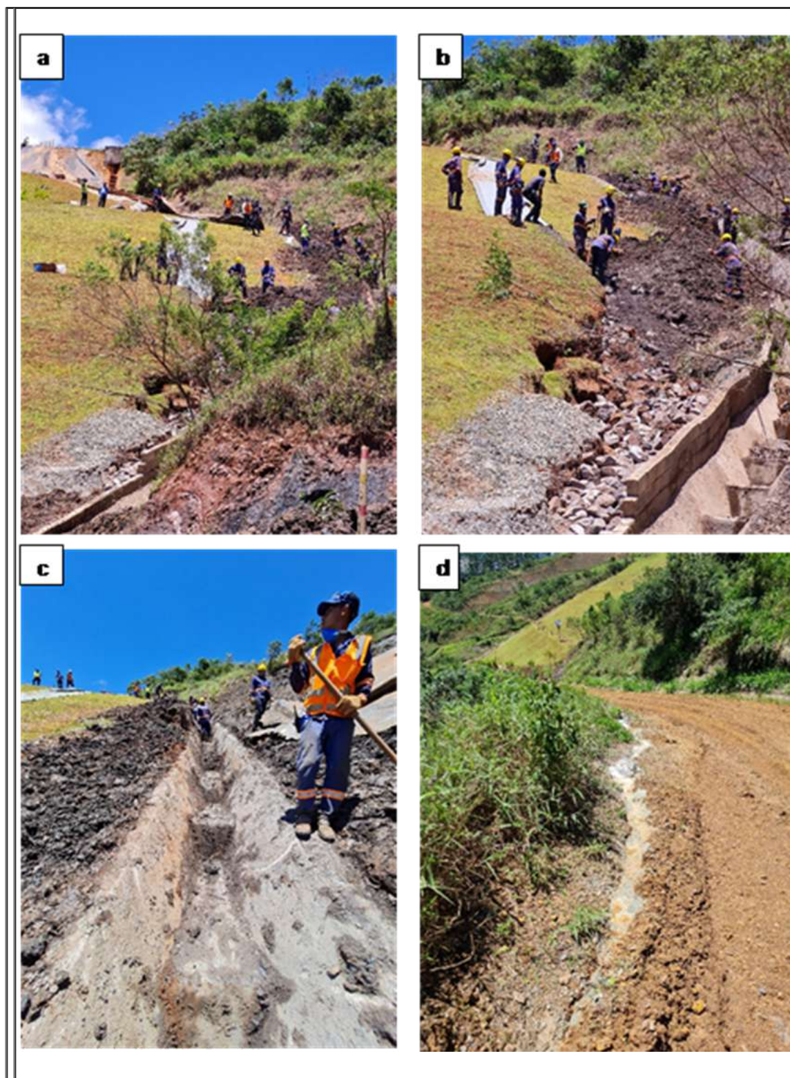
Figura 1. Medidas corretivas das anomalias identificadas na vistoria: a e b) homens trabalhando na correção das erosões no maciço do Dique de Sela; c) limpeza de canaleta que estava obstruída por escorregamentos da encosta da ombreira esquerda do Dique de Sela; e d) selamento de trinca acima de talude natural com calda de cimento.
