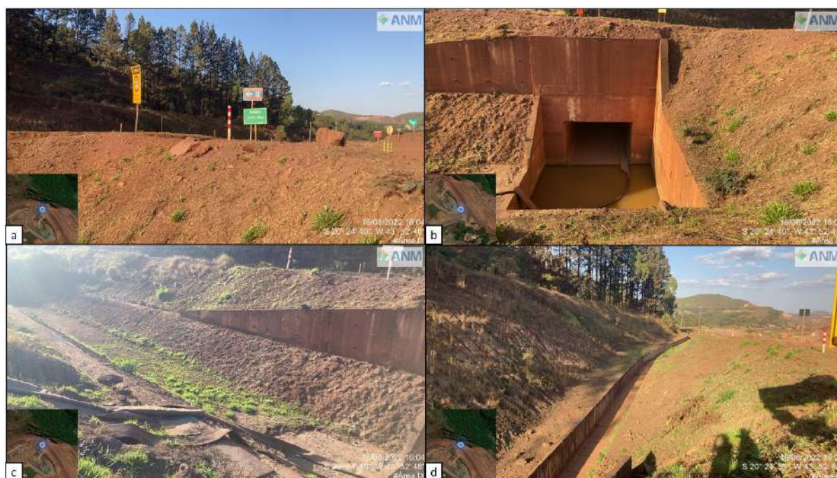
Figura 6- Sistema extravasor da estrutura (a) travessia acima da galeria (b) emboque da galeria (c) canal de aproximação escavado em seção trapezoidal (d) canal retangular em concreto.
