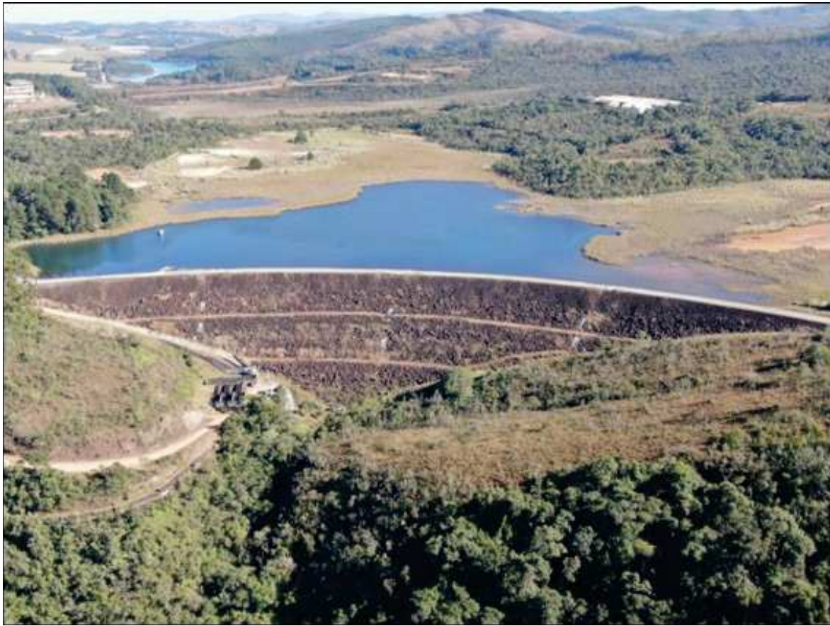
Figura 2.4 – Vista geral do talude de jusante por imageamento de drone
