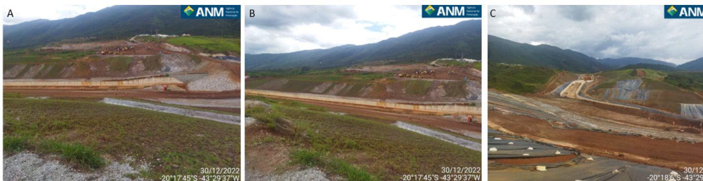
Figura 14 - Imagens do canal extravasor da Barragem Doutor. (A) Emboque do extravasor; (B) Canal proximal; (C) Canal distal, local de atividade das obras de readequação.
