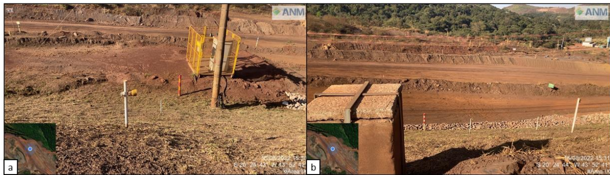
Figura 7- Exemplificação da instrumentação instalada na estrutura.
