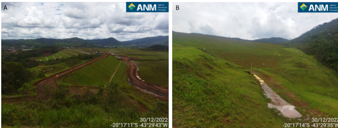
Figura 23 - (A) Face de montante; (B) Talude de jusante do Dique 3.
