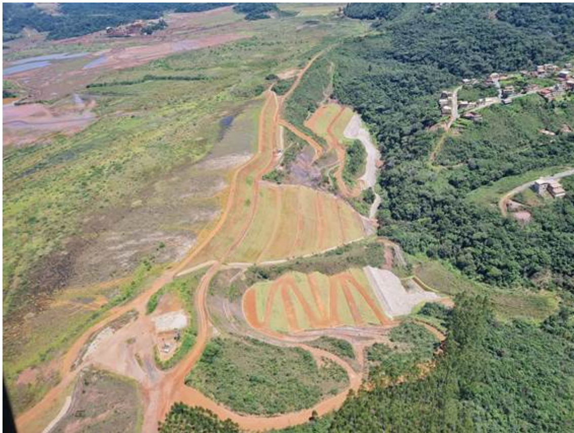
Figura 5. Visão aérea do Dique de Sela, cujo último talude refere-se a alteamento em parte à montante, e taludes adjacentes à ombreira direita, relativos à empilhamento drenado de rejeito.
