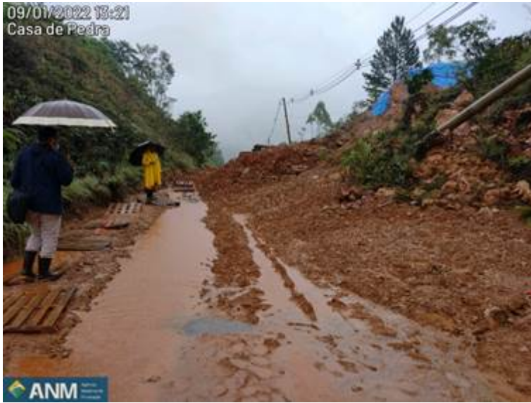
Figura 1. Escorregamento de encosta no acesso principal ao empreendimento.
