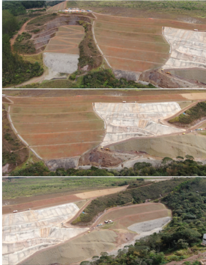
Figura 04: Dique de sela da barragem Casa de Pedra no município de Congonhas-MG
