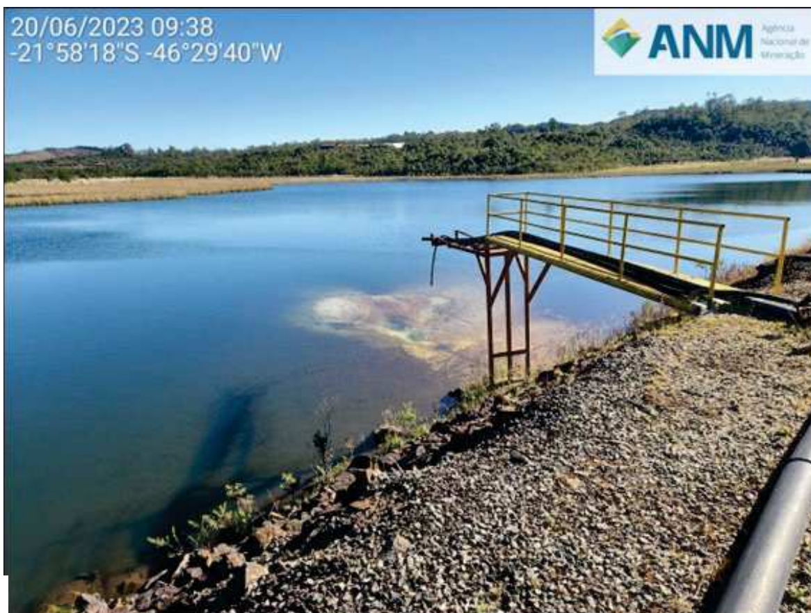
Figura 2.3 – Operação do reservatório no dia da vistoria
