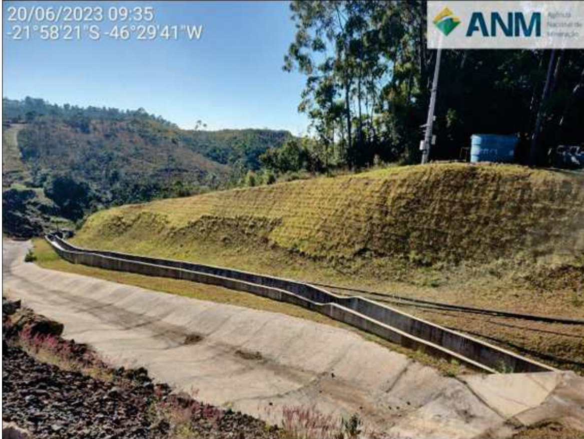
Figura 2.6 – Talude da ombreira direita
