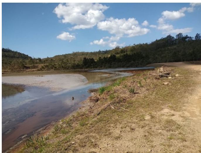
Foto 15: Dique D3, também se encontra assoreado. Fluxo de água ácida decorrente de surgência proveniente do Bota-fora 8.
