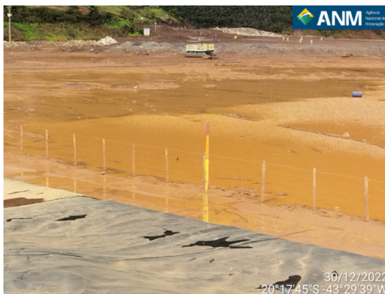
Figura 17 - Detalhe do controle utilizado pela Vale para a leitura do nível de altura da lâmina de água. Em vermelho tem-se o nível de emergência, localizado na cota 814,50m.
