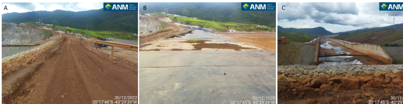
Figura 18 - (A) Passagem de veículos localizado na leira sem acúmulo de água ou encharcamento; (B) Geomembrana localizada sobre a leira para a sua proteção apenas com água acumulada decorrente de precipitação; (C) Reforço de enrocamento sem cicatrizes de passagem de água em sua superfície.
