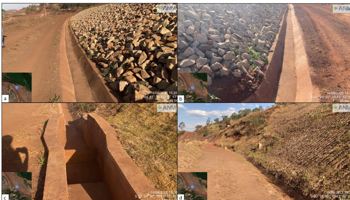
Figura 5- Dispositivos de drenagem superficial (a)Canaleta de berma (b) Canaleta de berma (c)Caixa de passagem (d) vista da berma e canaleta.
