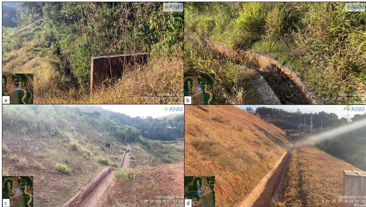
Figura 11-Dispositivos de drenagem superficial (a) Ombreira direita-superior (b) Ombreira direita-intermediário (c) canal ombreira esquerda (d) canaleta de berma.
