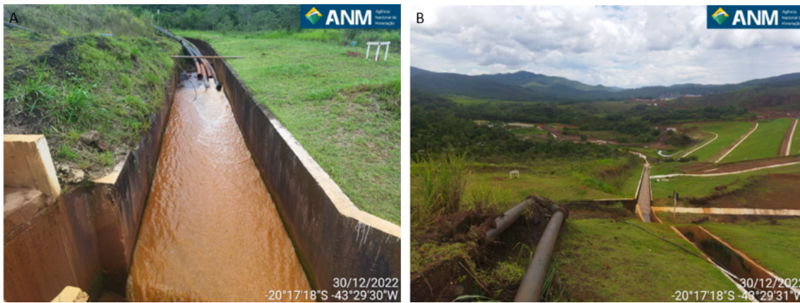
Figura 19 - (A) Localização da tubulação onde ocorre a saída de água redirecionada do reservatório no canal de drenagem superficial; (B) Canal de drenagem que direciona a água até o sump .
