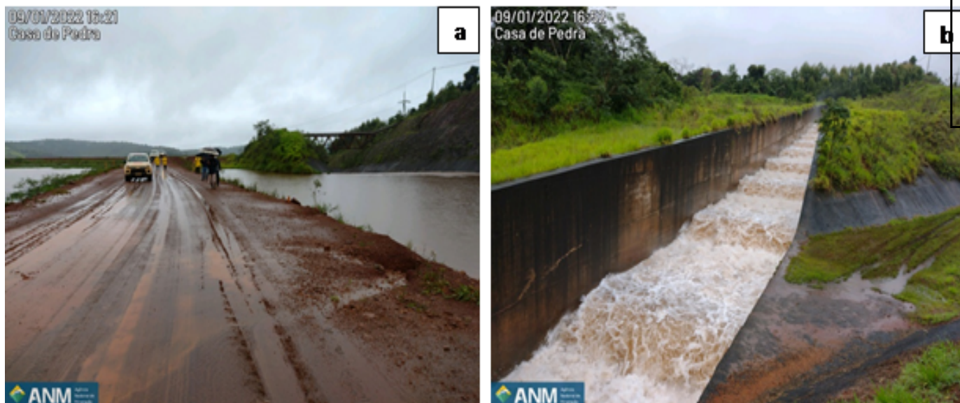
Figura 6. a) lago próximo ao emboque do extravasor com a finalidade de reter partículas finas; e b) extravasor da Barragem Casa de Pedra atendendo a um volume elevado de água.
