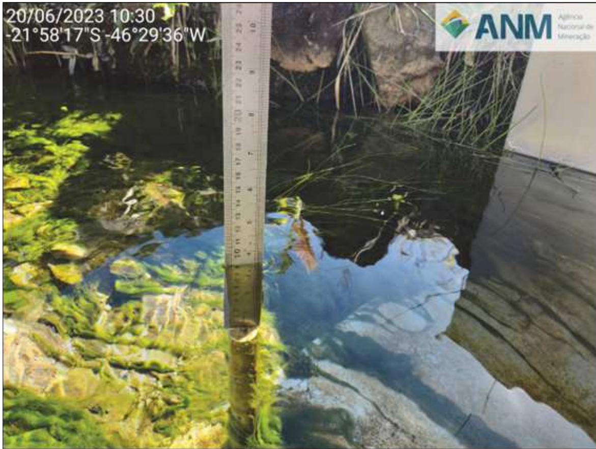
Figura 2.8 – Leitura manual do medidor de vazão da drenagem interna (ponto 27E)
