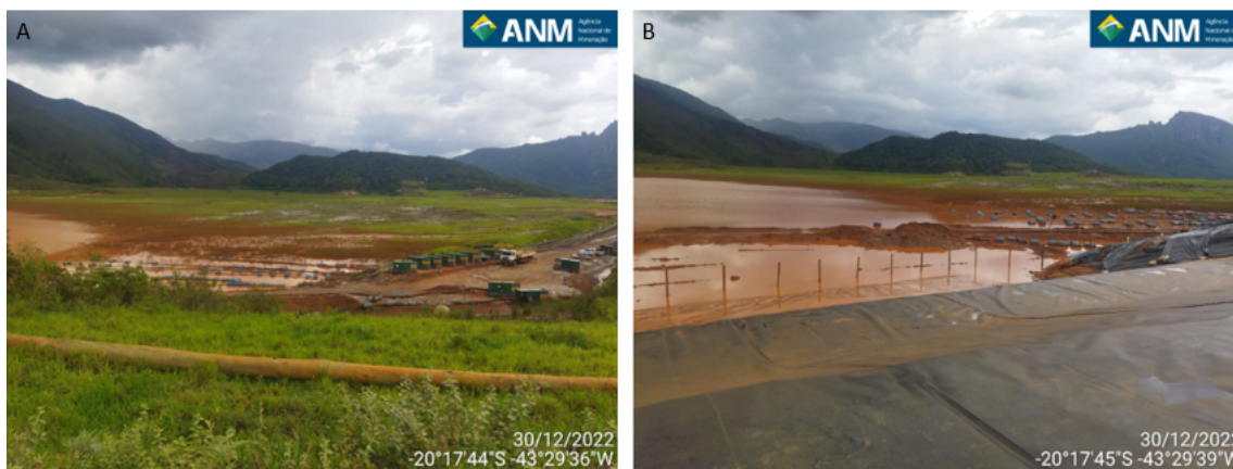
Figura 16 - (A) Sistema de bombeamento instalado para retirada da água acumulada no reservatório; (B) Detalhe da distribuição e posicionamento das bombas.
