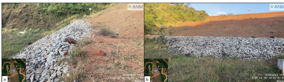
Figura 13- Pé da Barragem (a) vista do enrocamento (b) vista do talude de jusante da estrutura.
