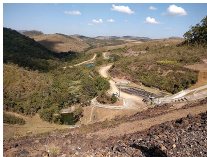
Foto 08: Vista a jusante da Barragem de Rejeitos. Na porção inferior do barramento, há o represamento e coleta por bombeamento da água ácida que percola da Barragem de Rejeitos. Ao fundo, é possível visualizar as Bacias D1 e D2.
