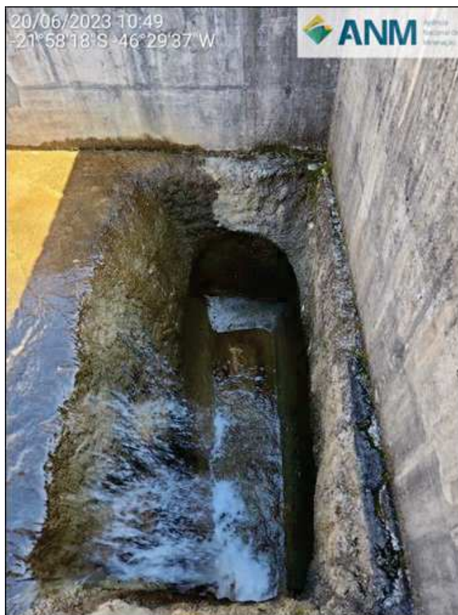
Figura 2.7 – Desemboque tamponado do sistema extravasor desativado
