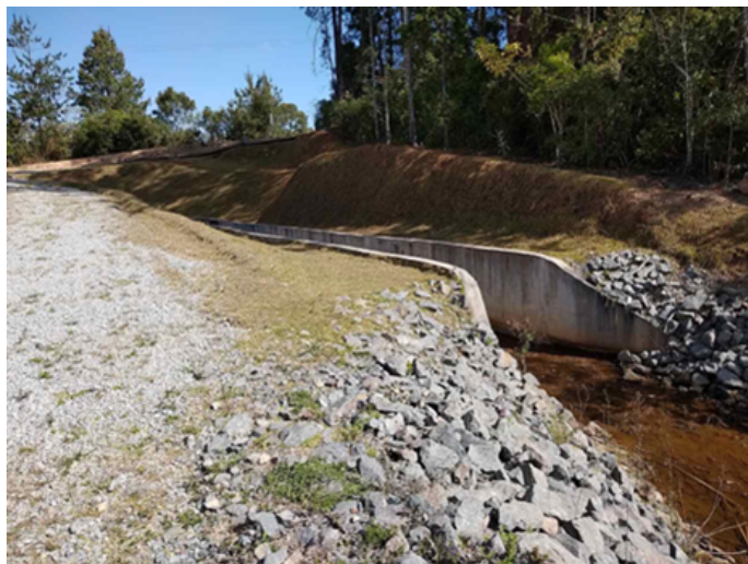
Foto 01: Tomada d'água do canal extravasor da Barragem de Rejeitos, construído em substituição ao vertedouro livre (tulipa) da barragem.
