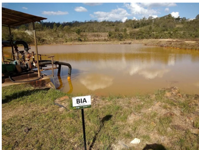
Bacia Ivan Antunes – BIA, onde ocorre a captação de água do Bota-fora 8. Parte significativa da drenagem ácida do Bota-fora 8.
