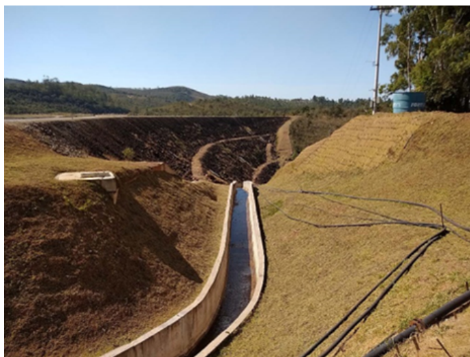
Foto 03: Canal extravasor e ombreira direita da Barragem de Rejeitos. Área de taludes gramadas e sem presença de cupinzeiros ou árvores.
