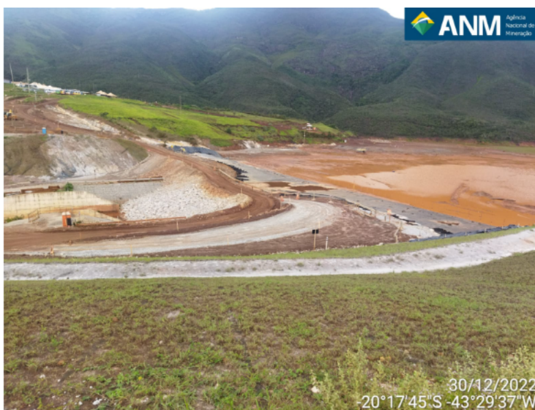
Figura 15 - Leira construída para a contenção da lâmina de água existente no reservatório.
