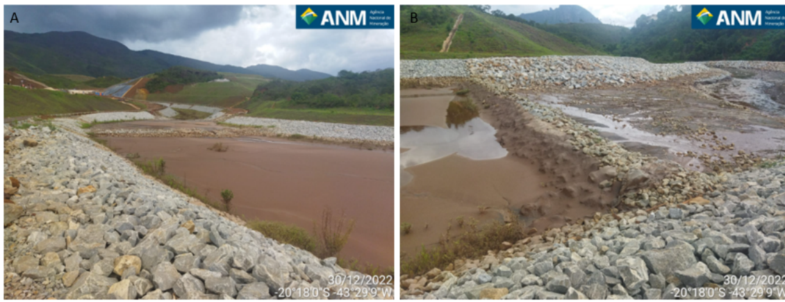
Figura 22 - (A) Proteção de enrocamento no desembocamento do canal extravasor para contenção de sedimentos; (B) Última proteção no fim do desembocamento. É possível visualizar que o enrocamento encontra-se preservado e não há indícios de vertimento, não havendo marcas de lama na porção a jusante do enrocamento. Ao fundo da imagem é o ponto de confluência entre o córrego e o canal extravasor.
