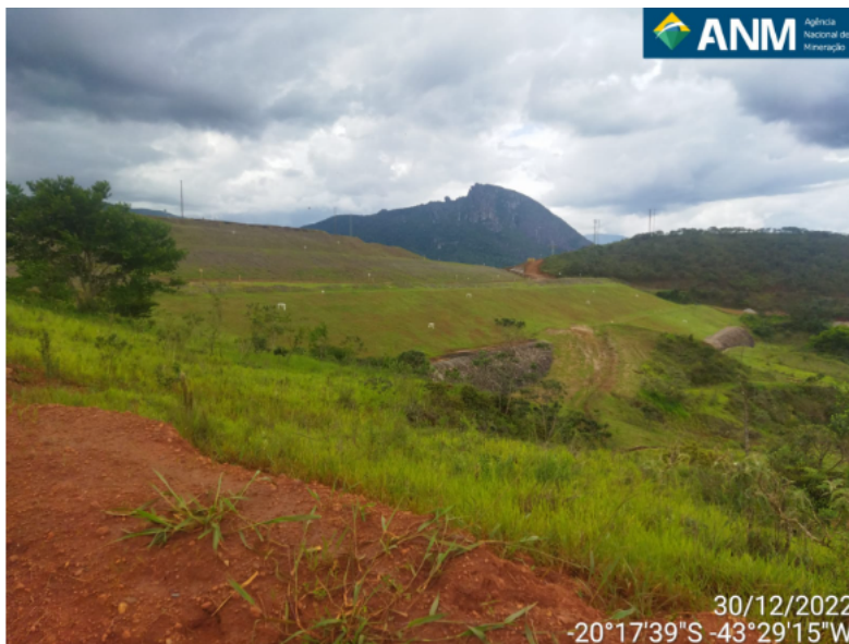
Figura 24 - Imagem do talude de jusante do Dique 1.
