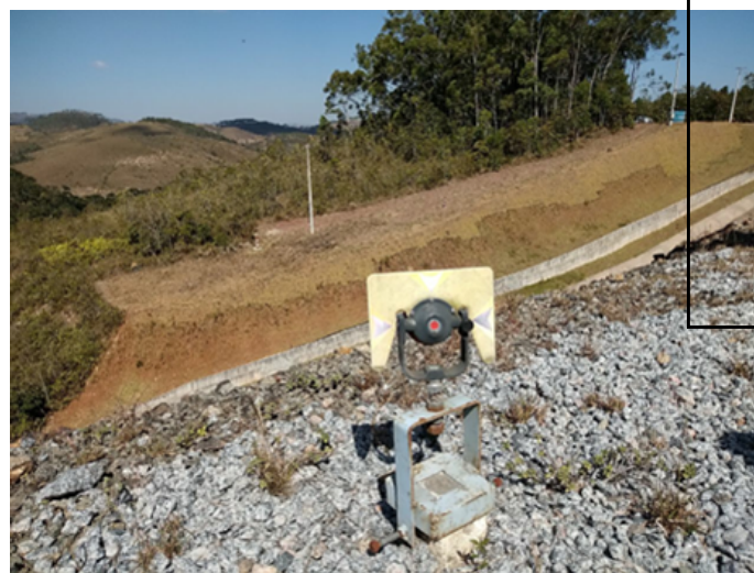
Foto 06: Marco topográfico para monitoramento de deslocamentos verticais e horizontais da Barragem de Rejeitos.
