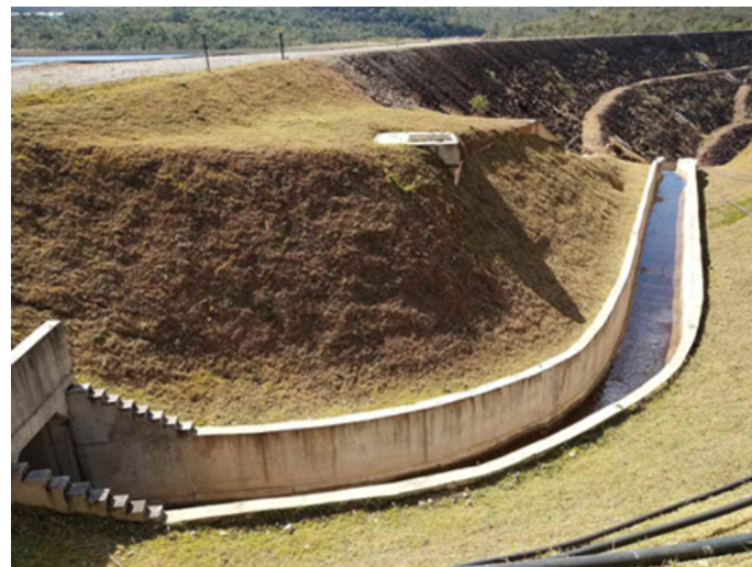
Foto 02: Canal extravasor e ombreira direita da Barragem de Rejeitos.
