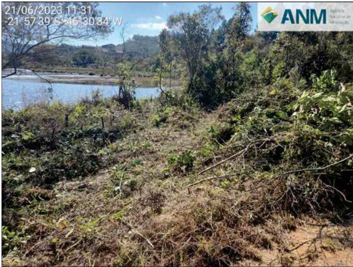
Figura 3.5 – Roçagem dos taludes do dique D3
