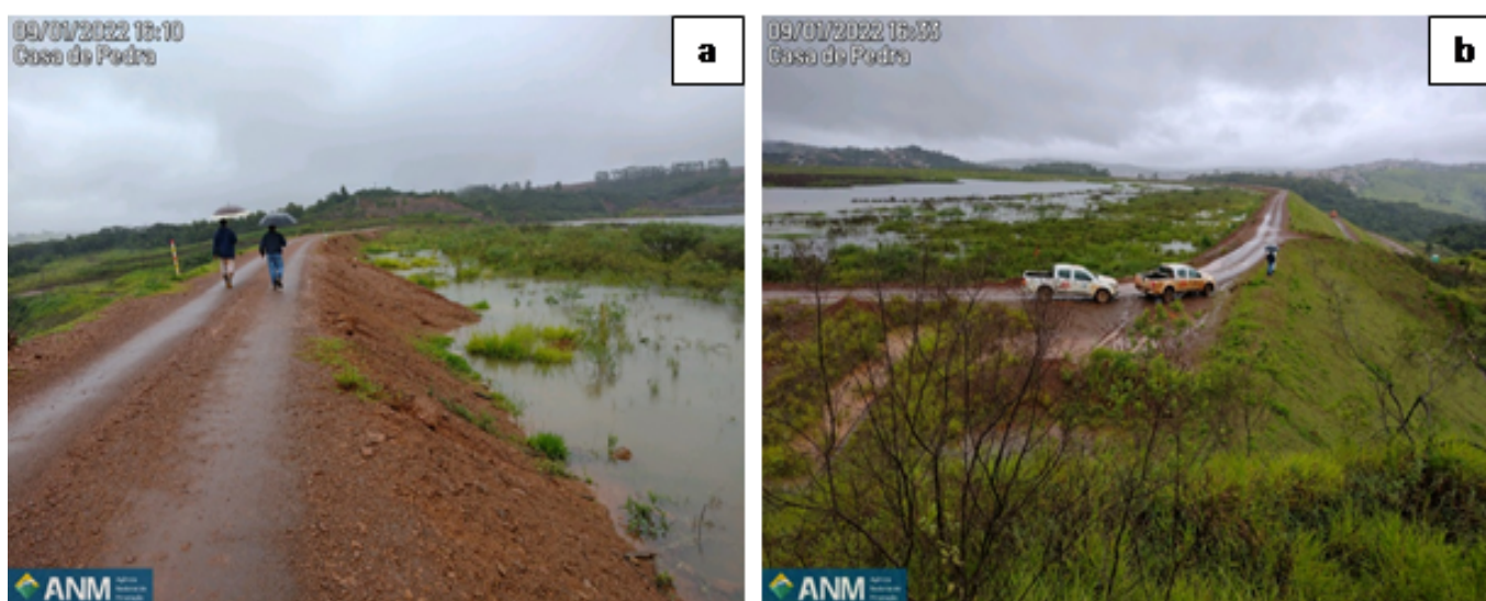
Figura 5. a) Crista da Barragem Casa de Pedra e talude de montante com borda livre; e b) visão do reservatório de Casa de Pedra com acúmulo de água devido às intensas chuvas.
