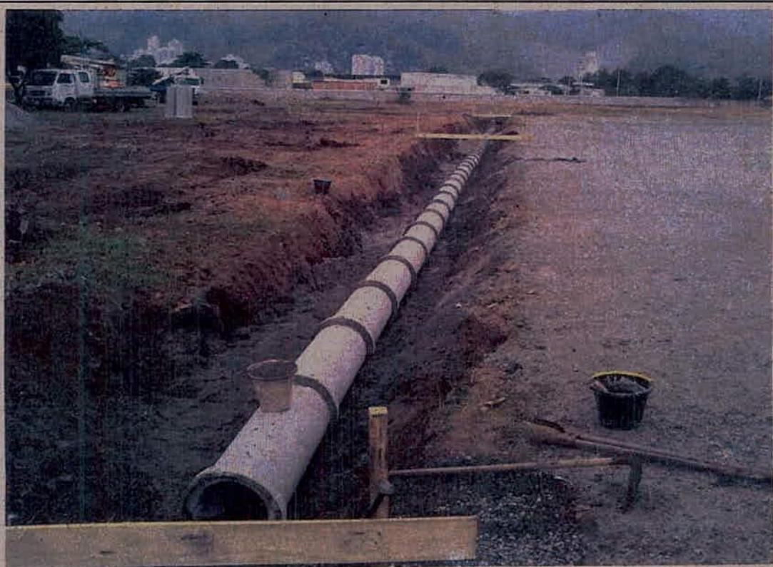
Foto 1 – Obras de canalização da drenagem junto à cabeceira 29
