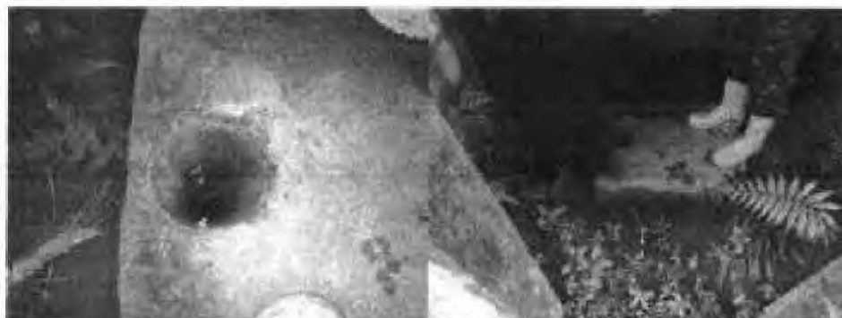
Figura 5: Poço tubular abandonado.
