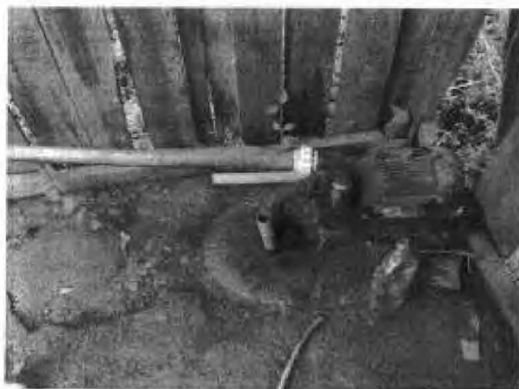
Figura 7: Sistema de bombeamento da água da cisterna
