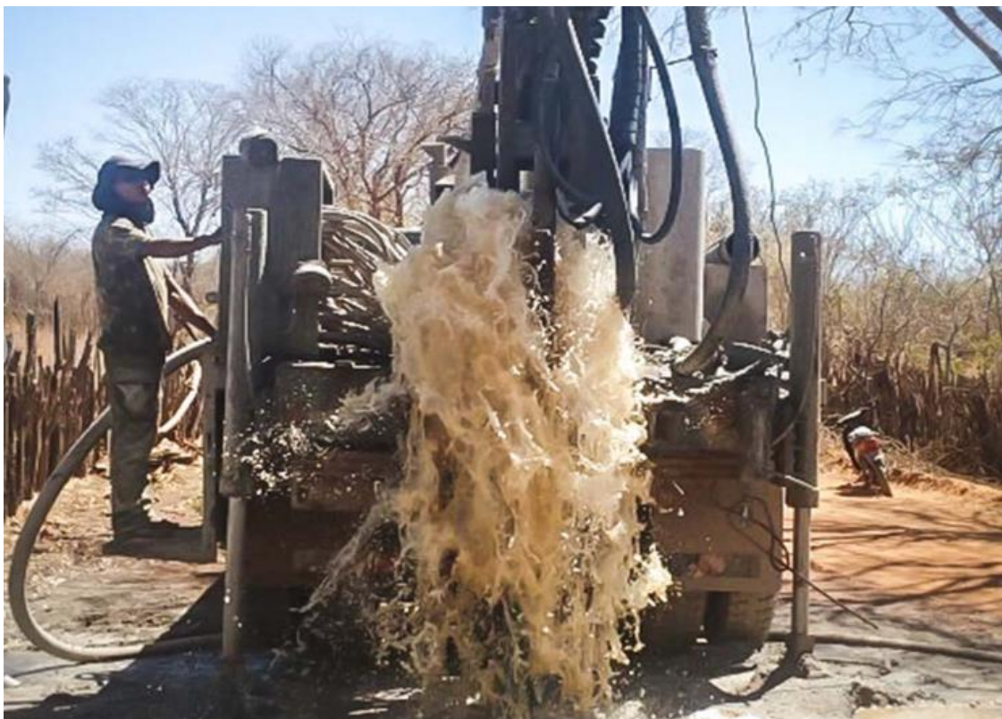
Foto 5 – Poço perfurado pelo Exército com sonda pneumática em terreno cristalino do semiárido.
