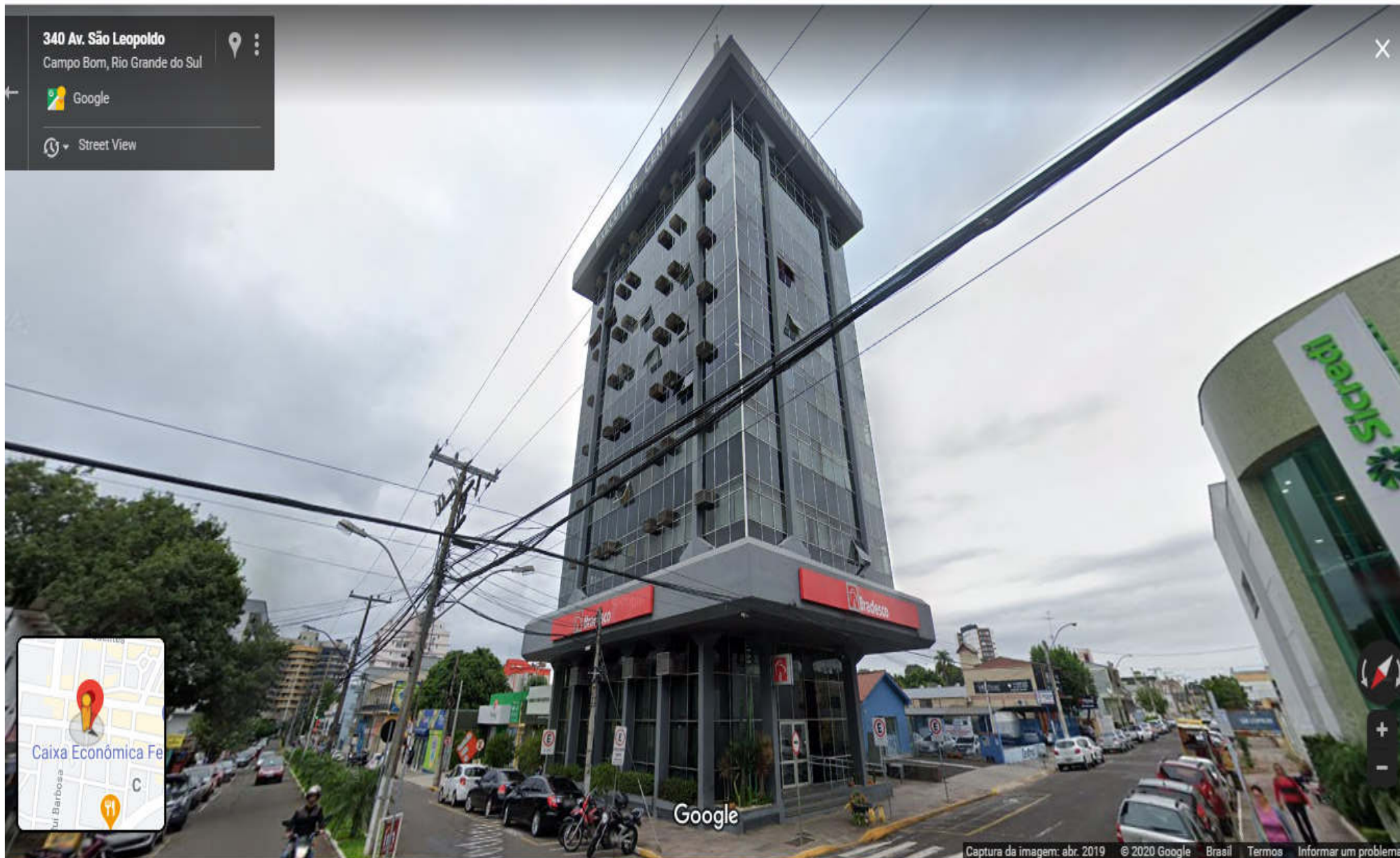
AV. SÃO LEOPOLDO, Nº 319 EM CAMPO BOM. NOTA-SE NO TELHADO ALGUMAS TORRES DE SI.
