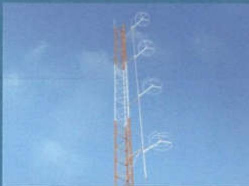
Antena para transmissão de FM, com polarização Circular. Podendo ser confeccionada com cabos coaxiais e divisores ou em linha EIA 1 5/8".
