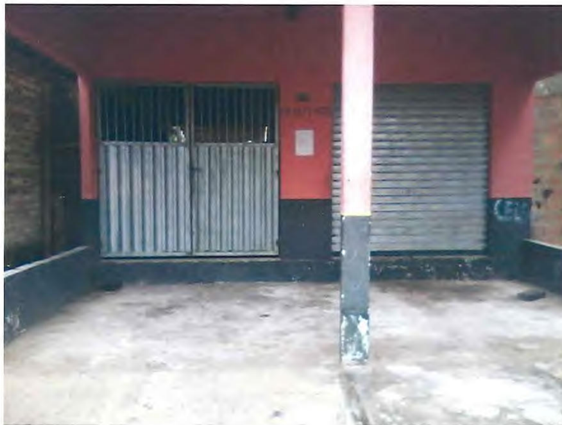
IMAGEM 02: Vista parcial das futuras instalações da Sede do Sistema de Radiodifusão em Governador Newton Bello (MA).
