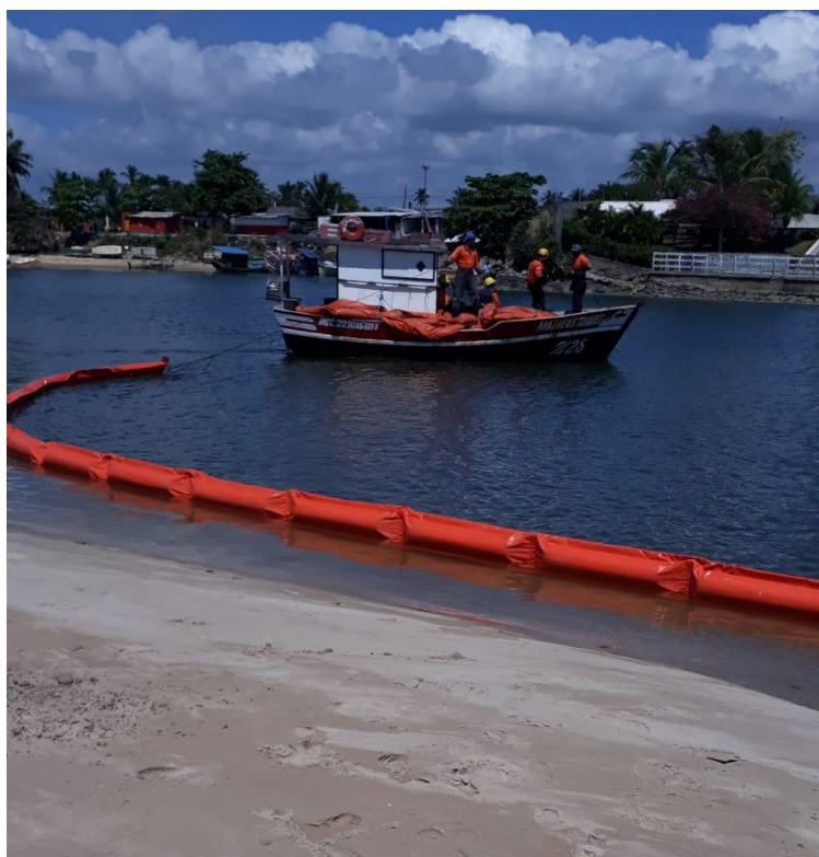
FOTO 06 E FOTO 07 – INSTALAÇÃO DE BARREIRAS DE CONTENÇÃO PORTUÁRIA – 26/10/2019.
