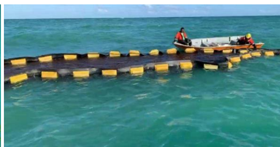
Cercamento da mancha de óleo pela prontidão ambiental do PortoRec. Fonte: TNK Ambiental
