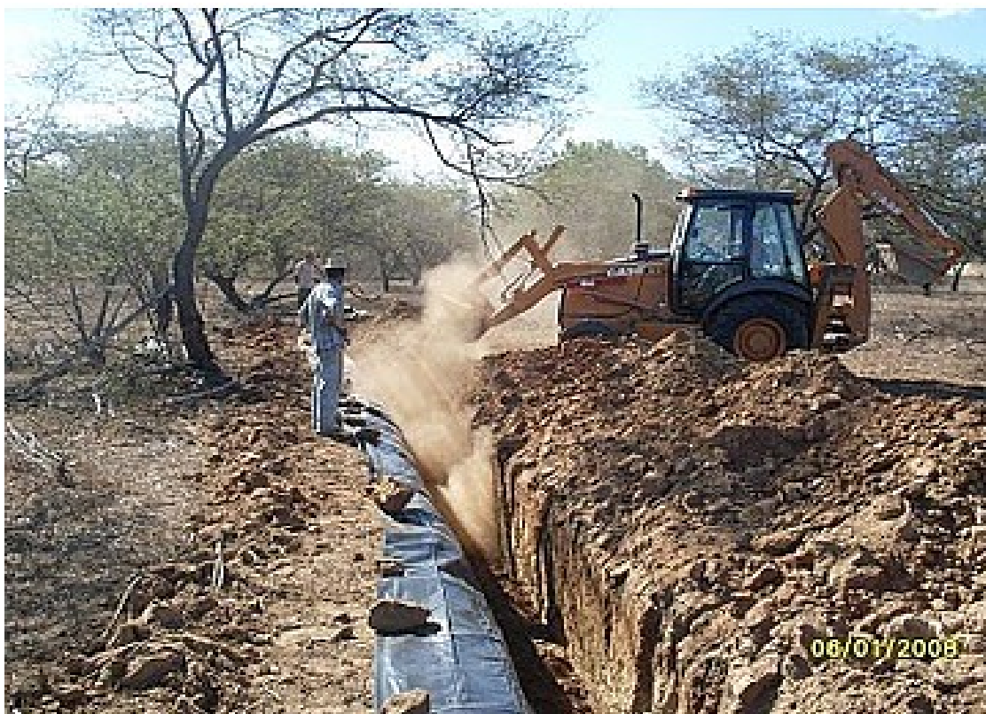
Foto 3 - Trincheira de barragem subterrânea aberta com retroescavadeira na aluvião de rio no semiárido.
