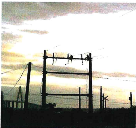
Fig 09: Equipe de linha viva desconectando os cabos do pórtico.
