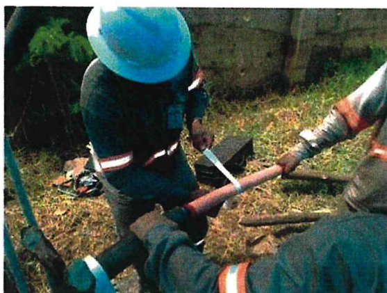
Fig 5: Lixamento da parte isolante do cabo
