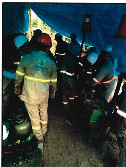
Fig 13: Equipe de Eletromecânica confeccionando as mufas.
