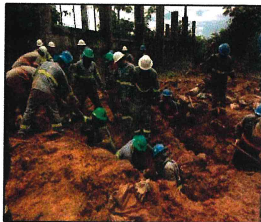
Fig 10: Equipes de apoio escavando para recuar os cabos.
