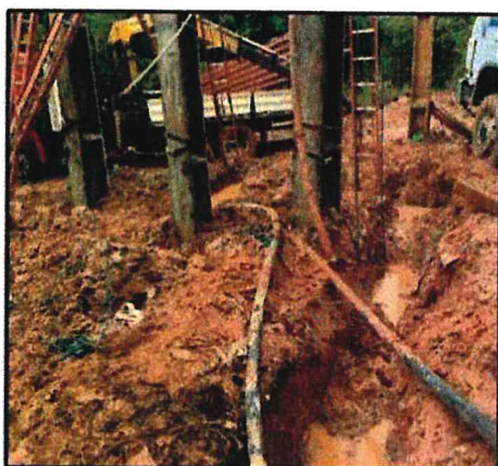
Fig 11: Escavação do terreno para retirada dos cabos
