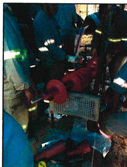
Fig 14: Equipe de Eletromecânica confeccionando as mufas.
