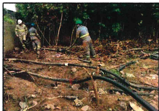
Fig 08: Recuo cabos subaquáticos da área protegida para área externa
