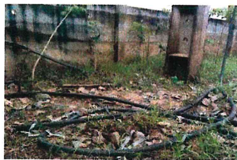
Fig 4: Cabos decapados, sem a blindagem
