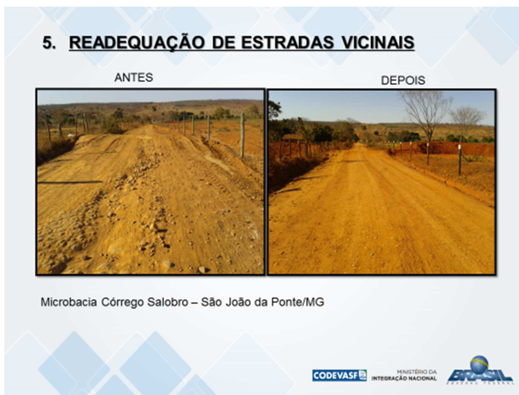
Figura 33: Readequação de estradas vicinais, com a construção de lombadas, canaletas laterais, “bigodes” e barraginhas.
