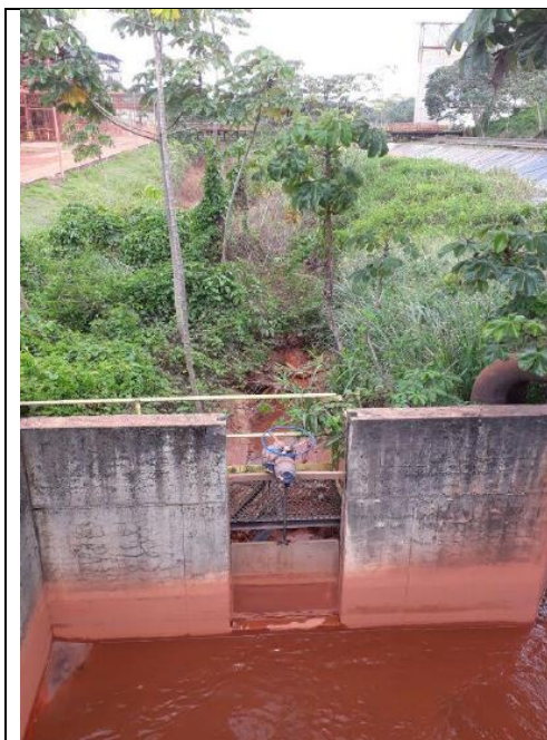
Figura 20 – Vista geral da estrutura
