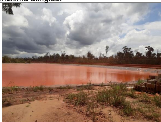
Figura 8 – Bacia de rejeitos (Depósitos de Resíduos Sólidos - DRS 1) com capacidade máxima atingida.
