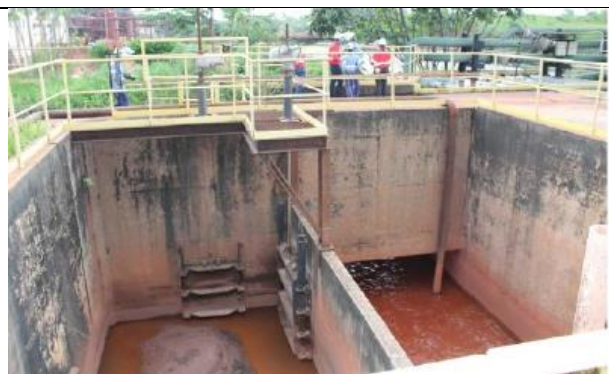
Figura 21 – Vista da saída da caixa de mistura, com detalhe para a existência de uma comporta, que pode permitir a passagem de líquido entre os dois compartimentos
