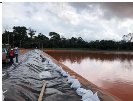
Figura 6 – Bacia de rejeitos (Depósitos de Resíduos Sólidos - DRS 1) com capacidade máxima atingida.
