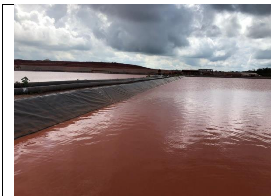
Figura 5 – Bacia de rejeitos (Depósitos de Resíduos Sólidos - DRS 1) com capacidade máxima atingida.
