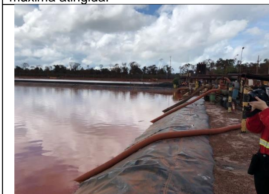
Figura 7 – Funcionários da Hydro Alunorte drenam o conteúdo da Bacia de rejeitos (Depósitos de Resíduos Sólidos - DRS 1).
