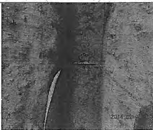
Foto de vala escavada, na fase de reaterro, com aproveitamento do material da escavação (lado direito da foto).
