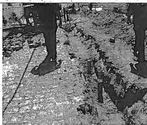
Foto de vala escavada, na fase de reaterro, com aproveitamento do material da escavação (lado direito da foto).
