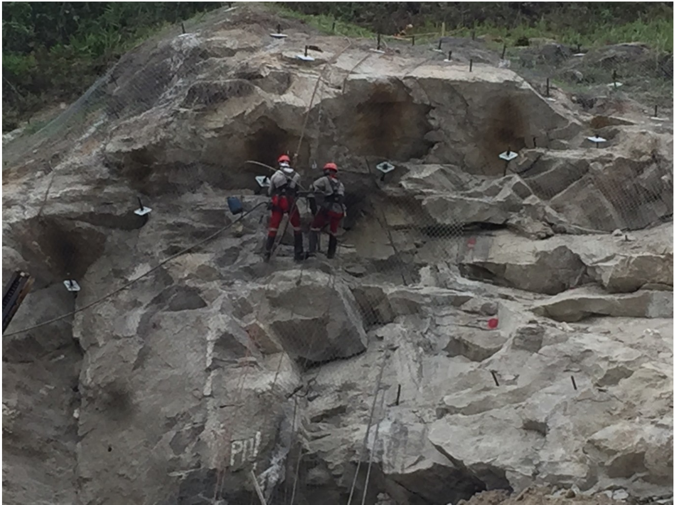
Obra de contenção de encosta
