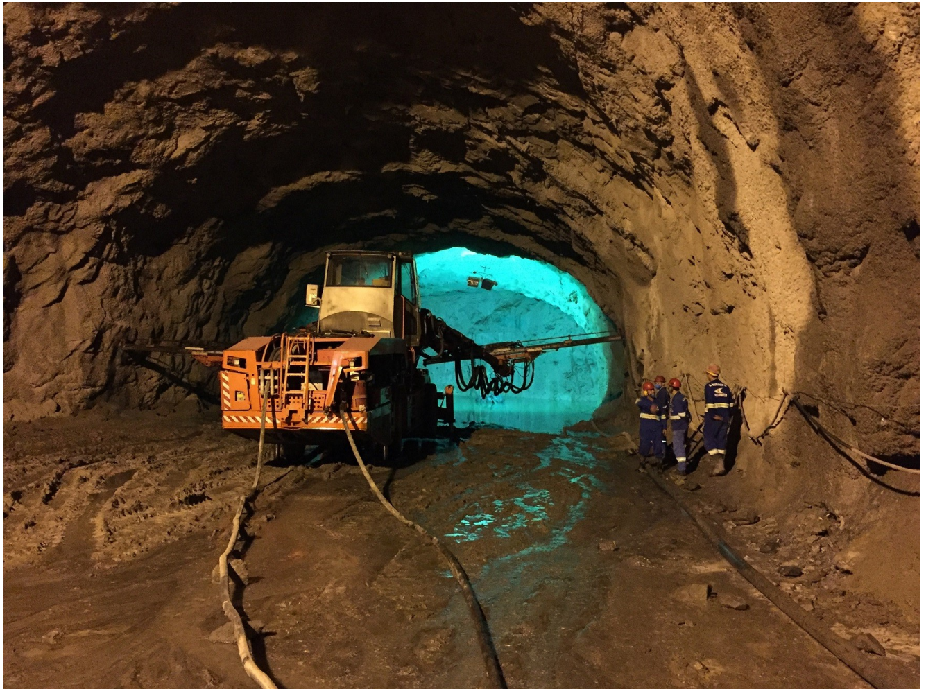
Obra do Túnel - Equipamento Jumbo
