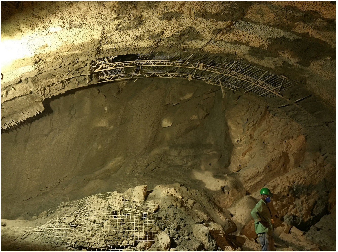
Obra do Túnel - Cambota e Concreto Projetado
