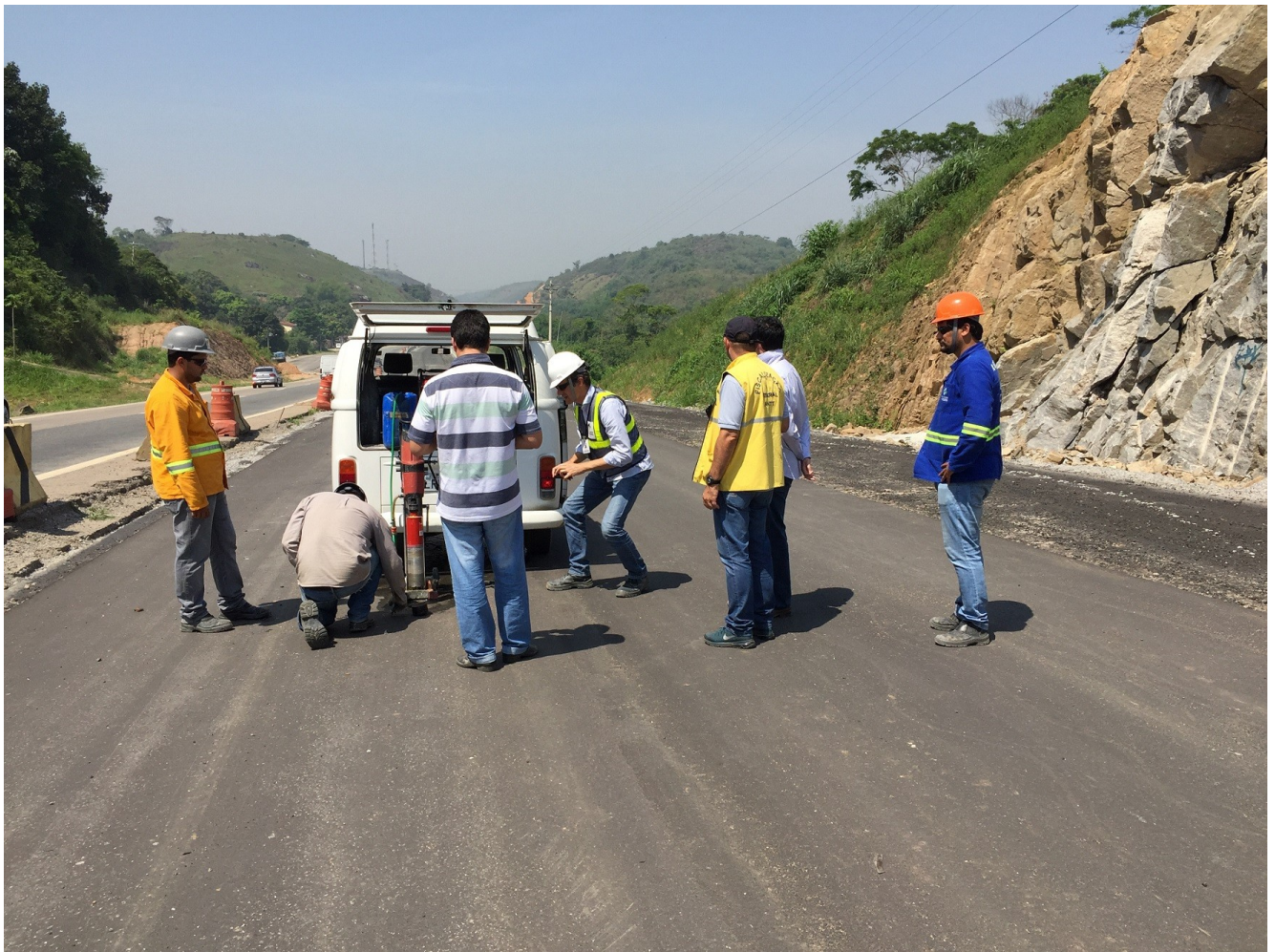
Execução de furos de inspeção
