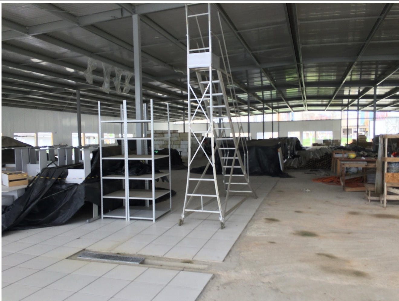
Refeitório e cozinhas do canteiro não concluídos
