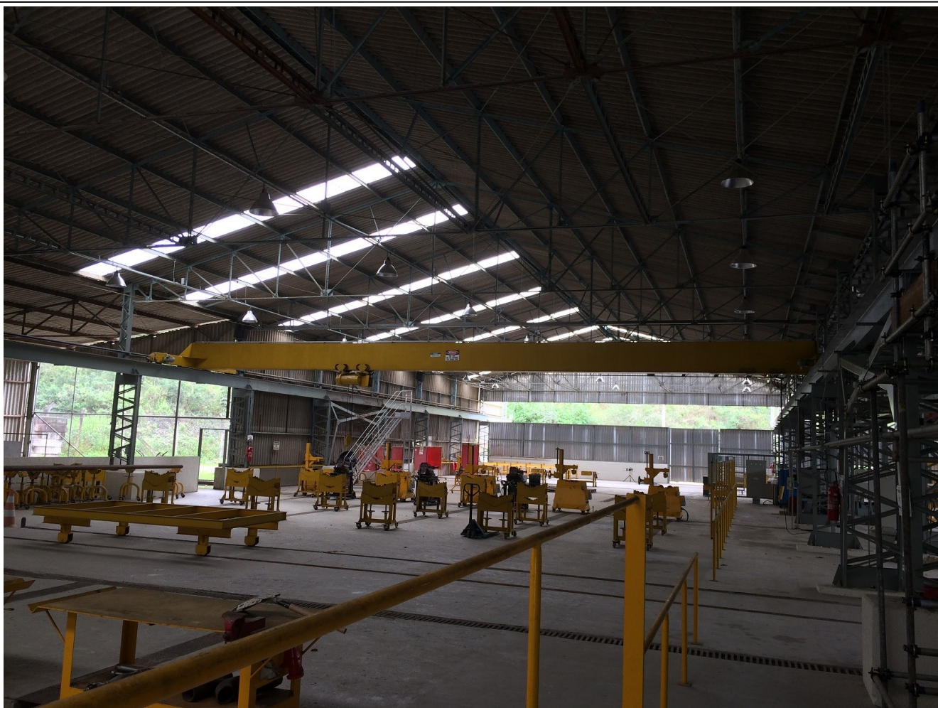
Reforma de oficina e instalação de equipamentos de pipe-shop - ferríticos
