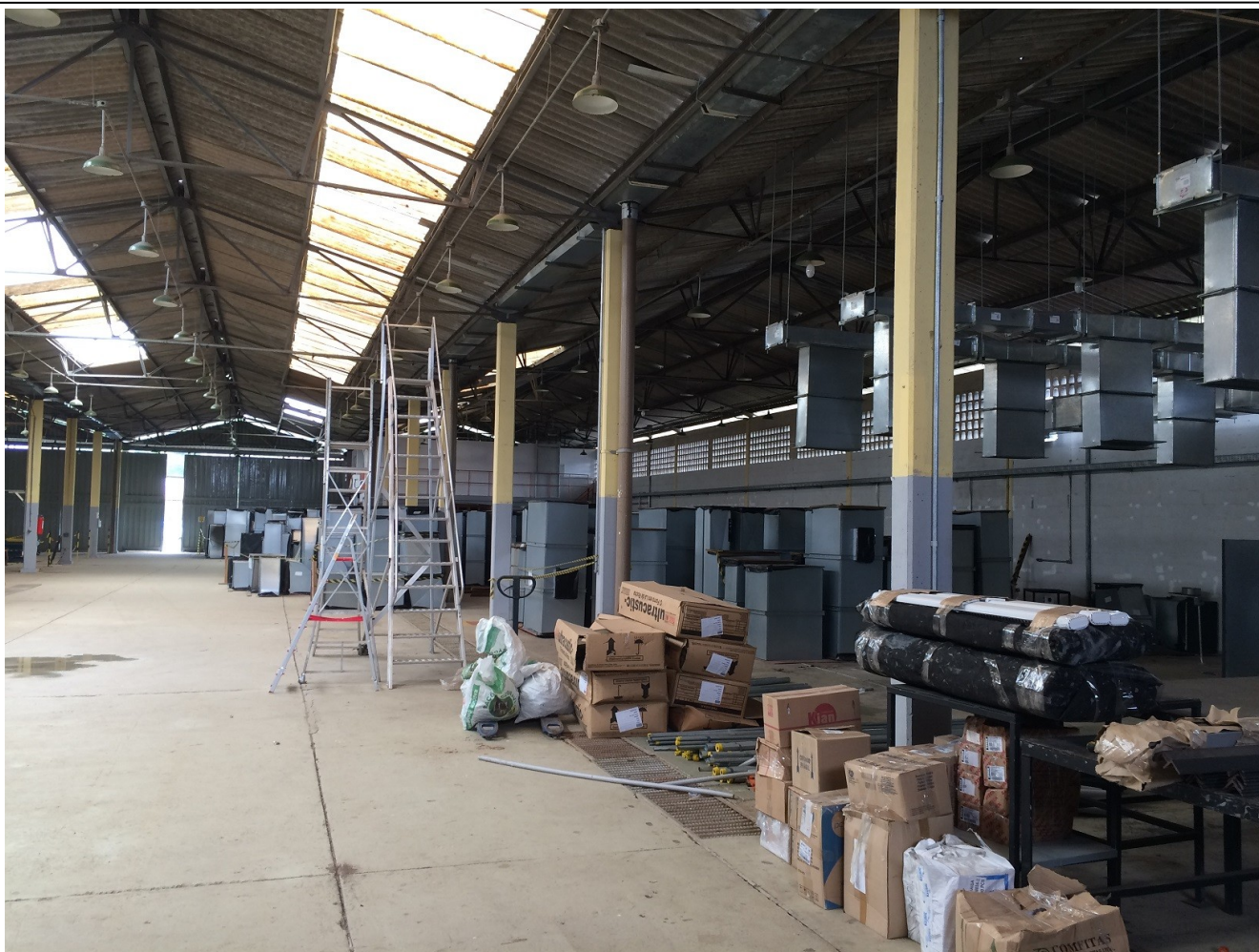
Reforma de oficina para montagem de dutos
