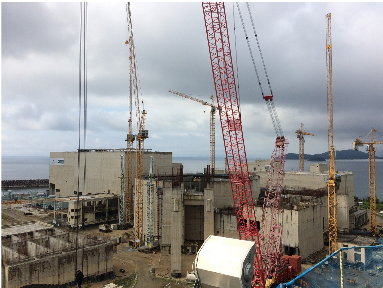
Vista Geral das Obras Cíveis
