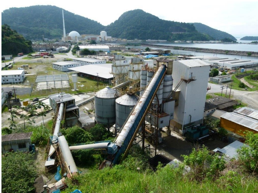
Figura 2 – Visão panorâmica do canteiro de obras de Angra III, com a central de concreto em primeiro plano. Ao fundo as usinas de Angra II (esférica), semelhante a Angra III, e Angra I (cilíndrica)
