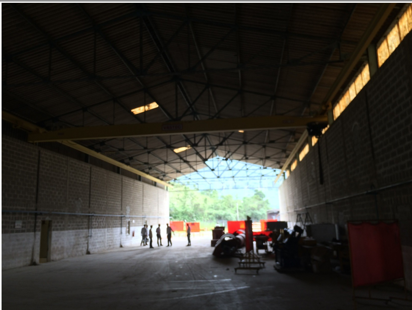
Galpão em reforma para pipe-shop de austeníticos
