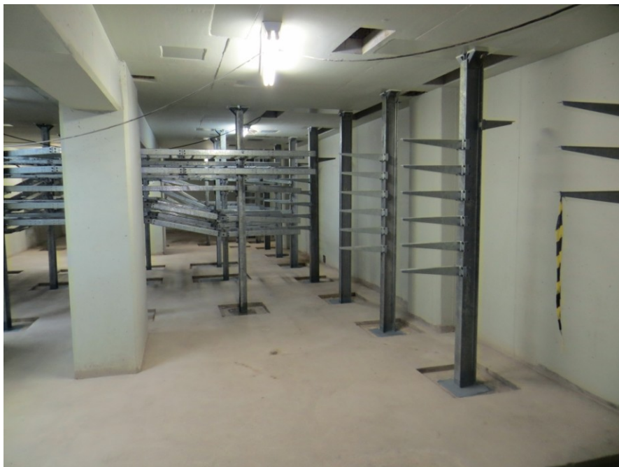
Figura 4 – Início de montagem eletromecânica no Edifício de Controle (UBA)
