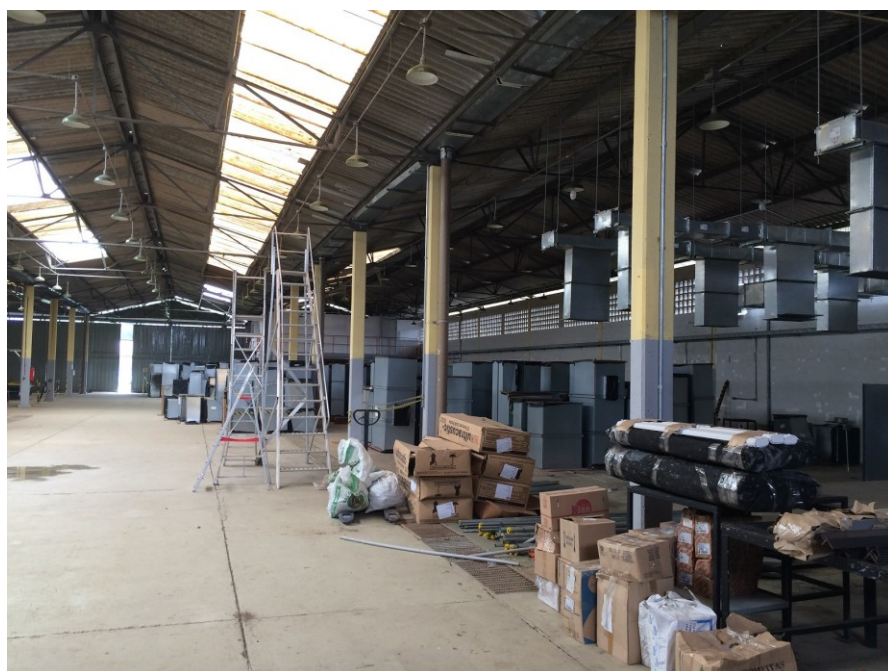
Figura 3 – Reforma de oficina para montagem de dutos
