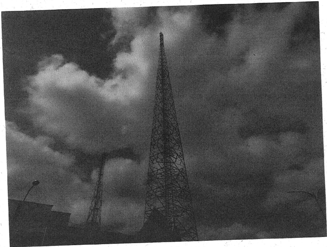
Torre de transmissão da TV UFMA, com 110 metros de altura
