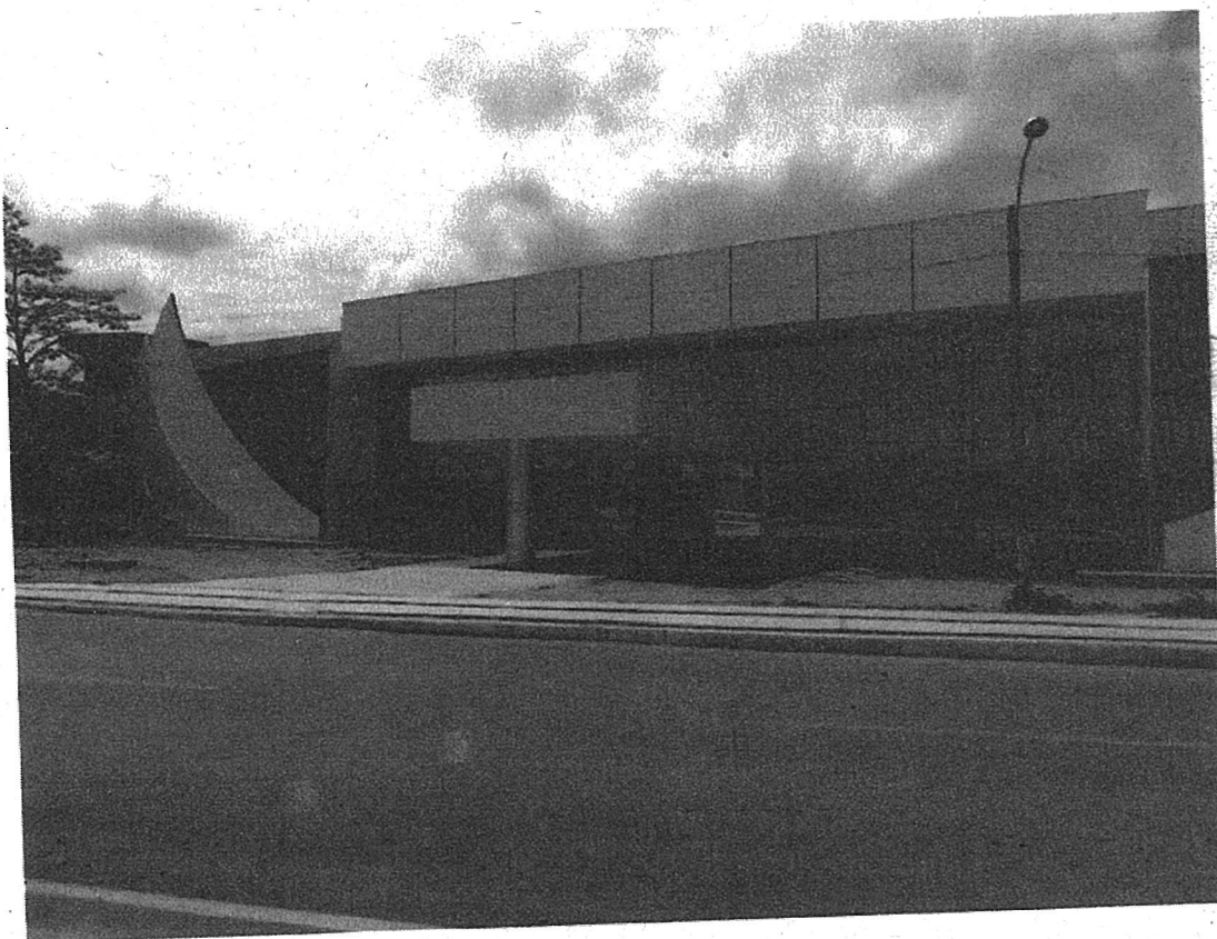
Vista frontal do prédio da TV UFMA, totalmente concluído
