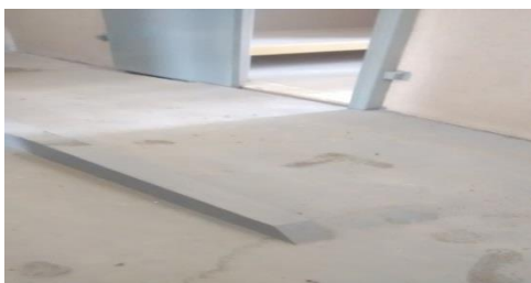
Rampa de acesso à cela
