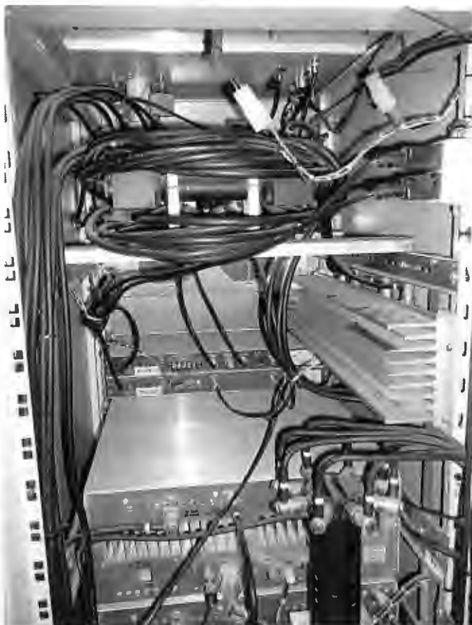
Transmissor Reserva: Vista Traseira - Conexões e saída de RF
