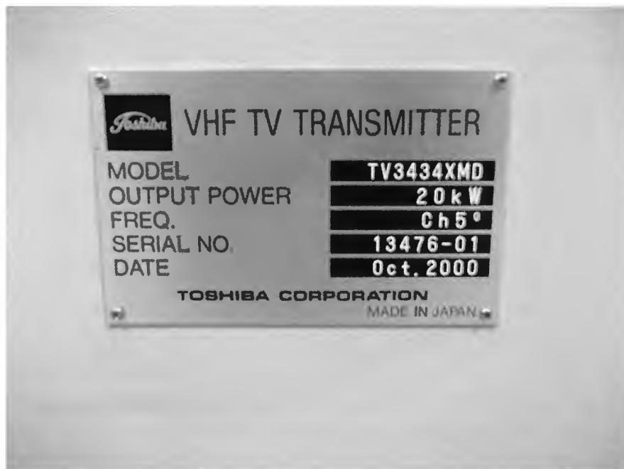
Transmissor Principal: Plaqueta de identificação
