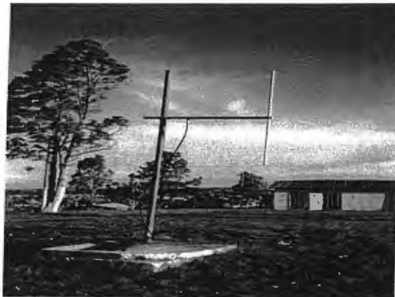
Mostra do elemento da Antena
