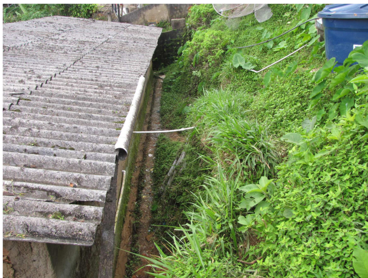
Figura 9. Exemplo de corte de talude muito estreito para instalação da casa.
