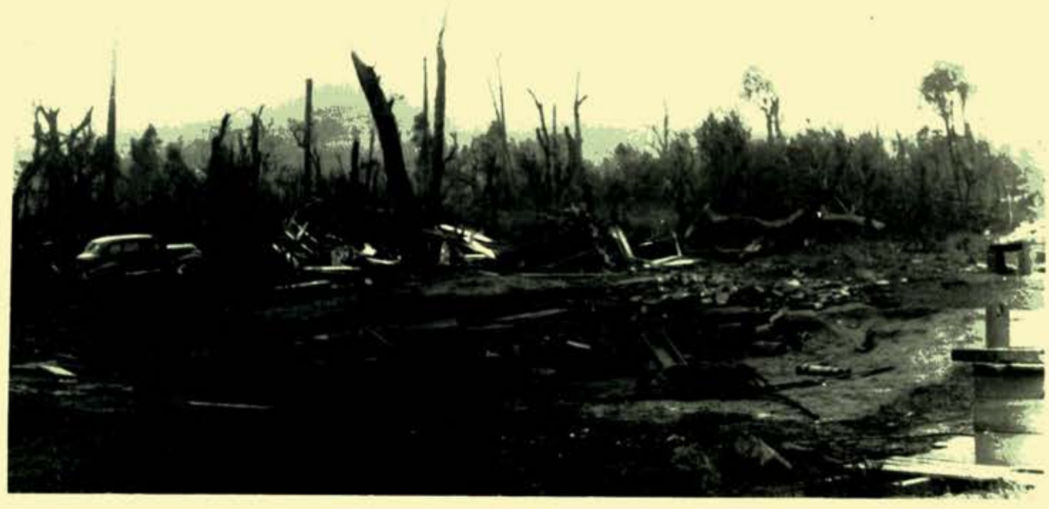
Residencia de propriedade de EUCLIDES WOITEXEN e que encontrava-se alugada para João Pereira. Foi totalmente destruida.
