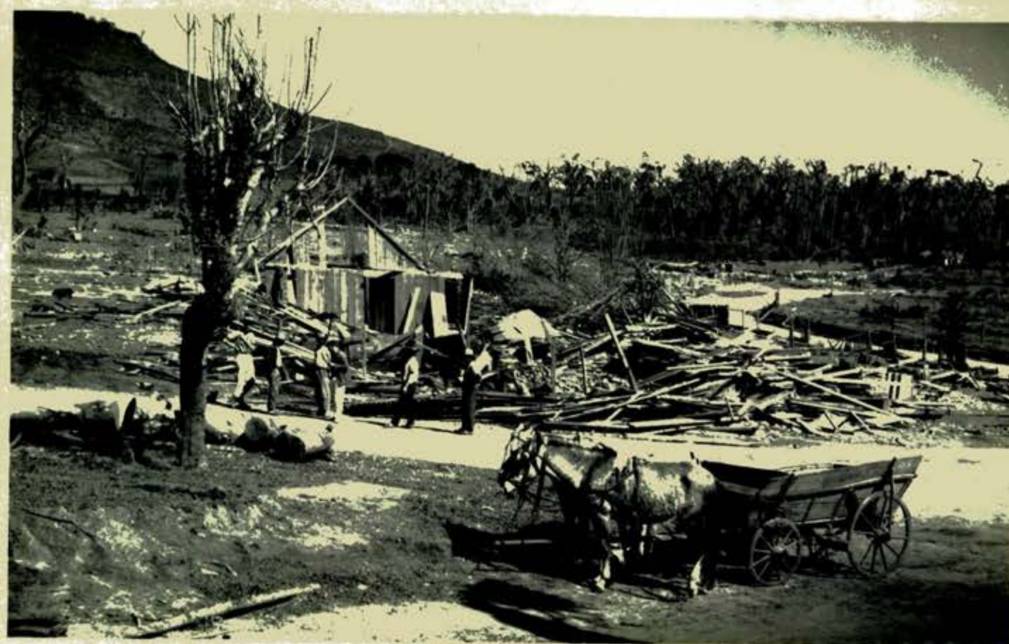
Vista da residencia do Sr. JOÃO REINERT FILHO, que foi completamente destruída.
