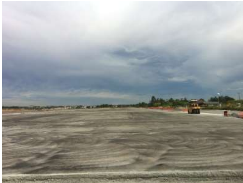
Execução da obra de ampliação do pátio – 11/12/2012
