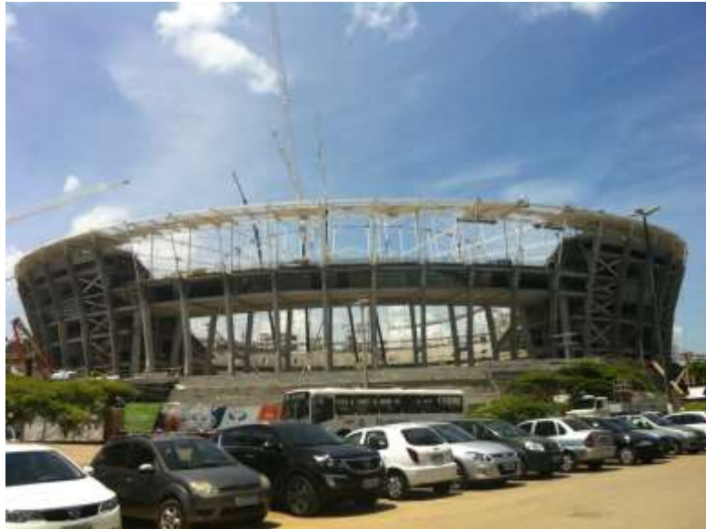
Visita da Subcomissão da Copa ao Estádio Fonte Nova com 82% de execução Formato de ferradura
