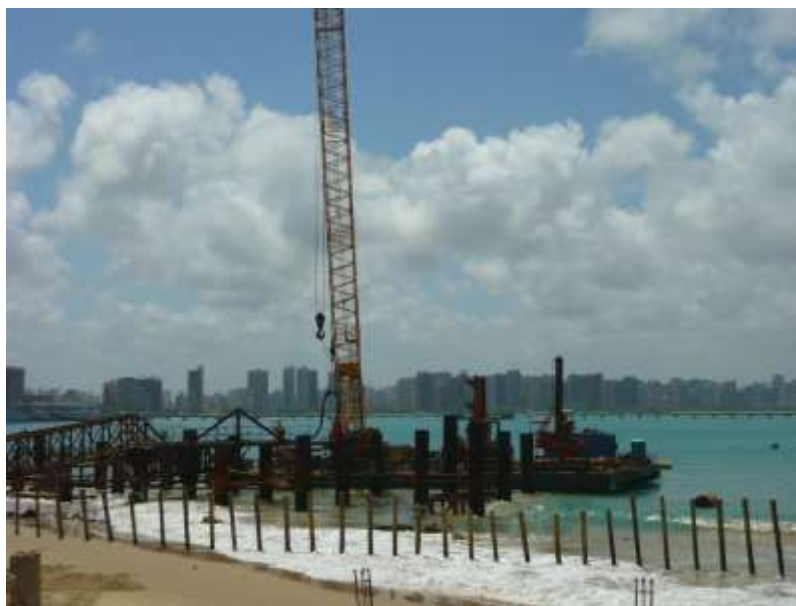
Porto Fortaleza – Obras de contenção e construção do cais
