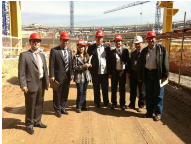
Comitiva da Subcomissão em visita às obras do Maracanã
