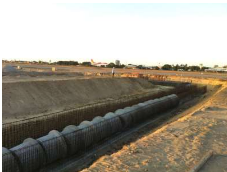
Obras no aeroporto de Fortaleza
