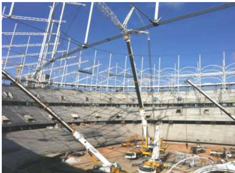
Fonte Nova nov/12: Içamento da cobertura
