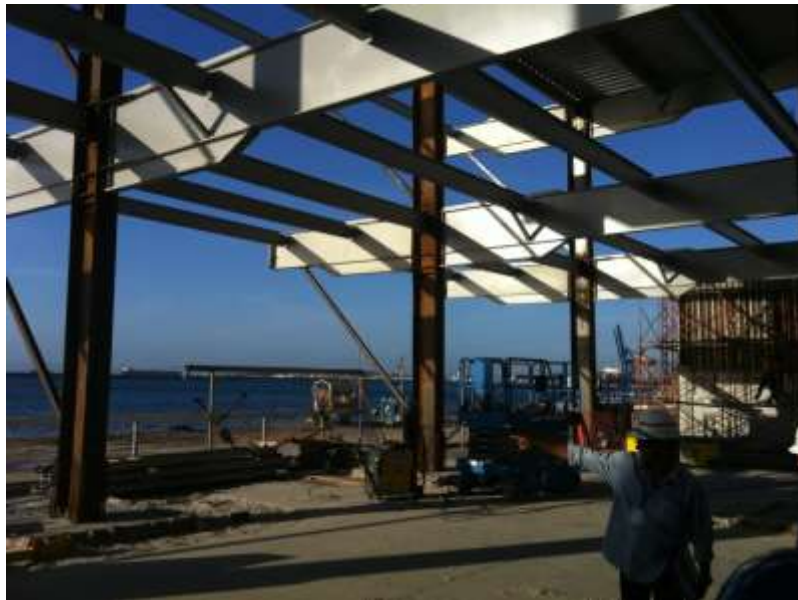
Porto de Salvador - Construção do Terminal de Passageiros
