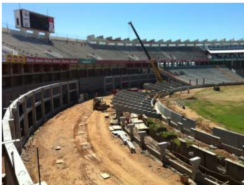
Construção da arquibancada inferior mais próxima ao gramado
