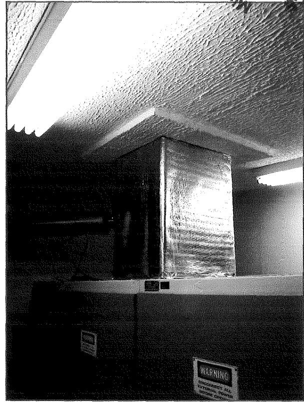
Figura 22 – Vista traseira e dispositivo de resfriamento forçado para o Transmissor Principal – FM – 35B
