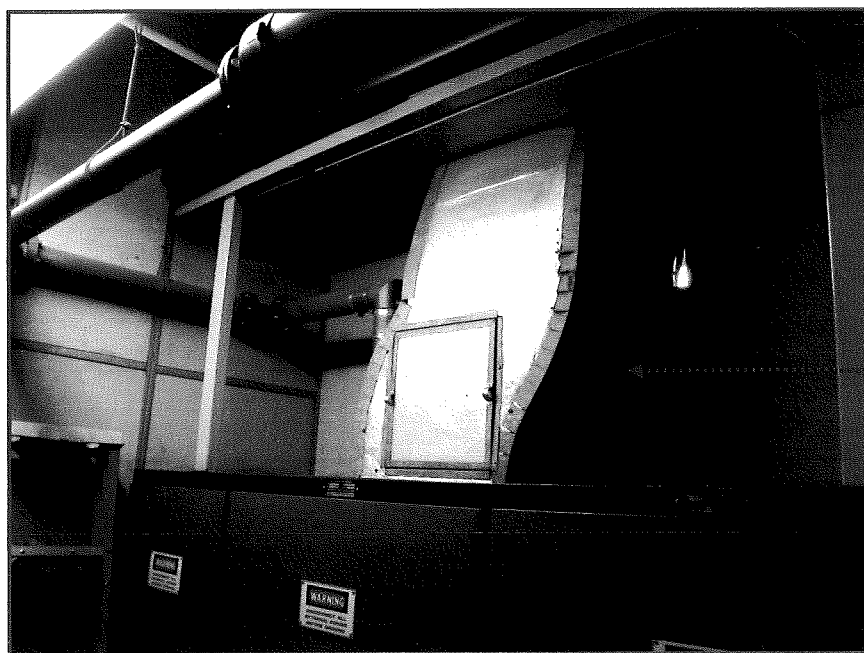
Figura 17 – Dispositivo de Resfriamento Forçado para o Transmissor.
